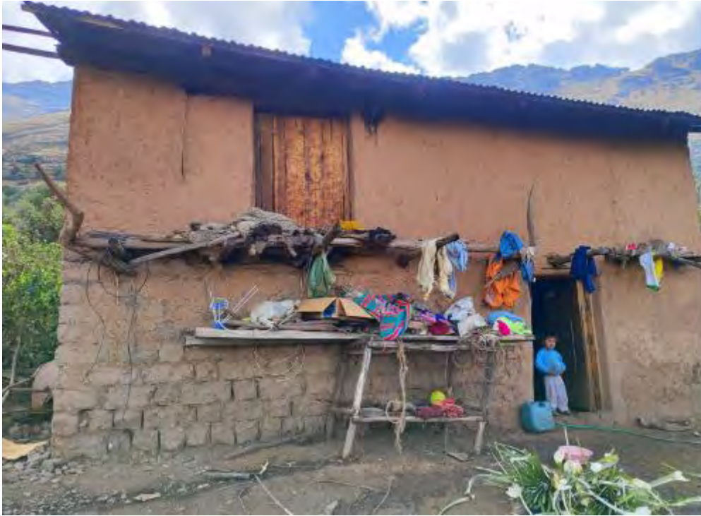
Figura 9. Vivienda de adobe de dos pisos en la comunidad de Tacllapata. Captura propia.
