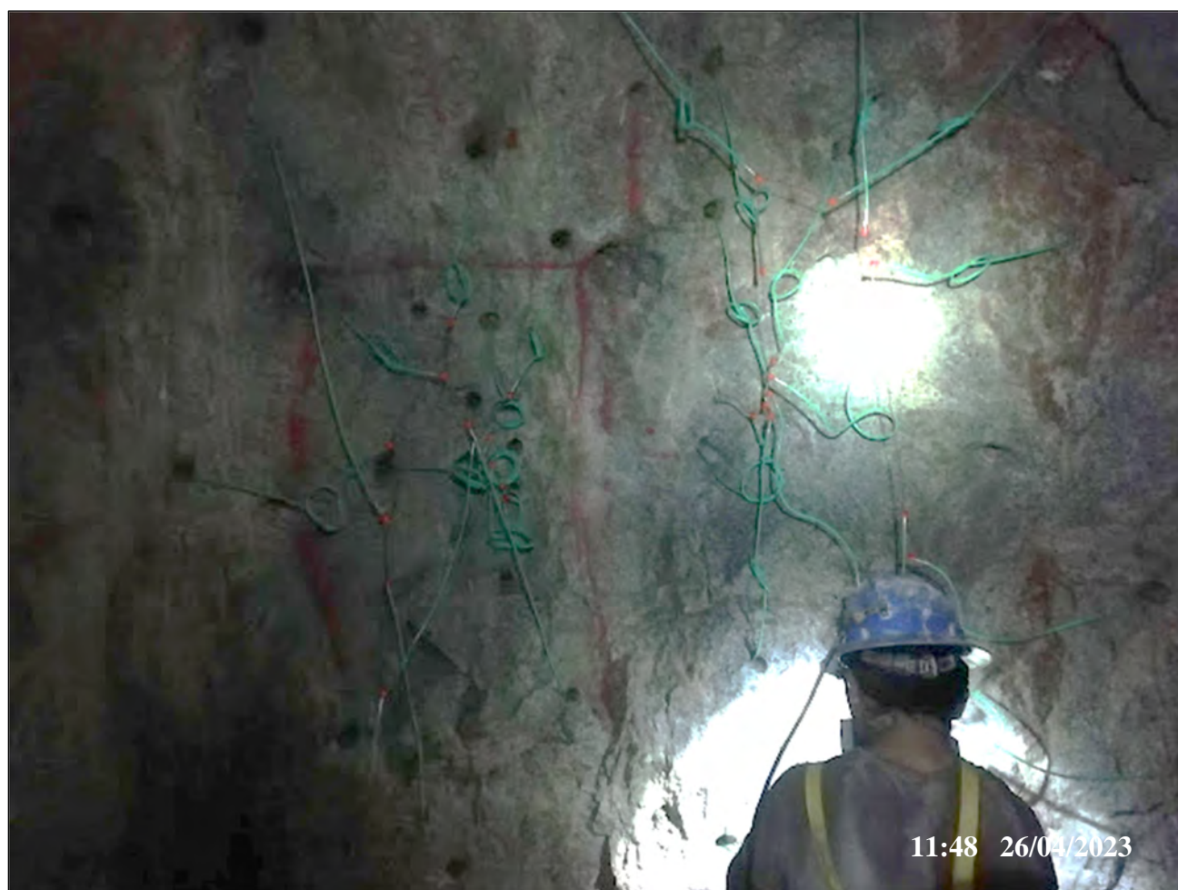
Figura 27. Carguío de taladros con guías Carmex en frentes Horizontales
