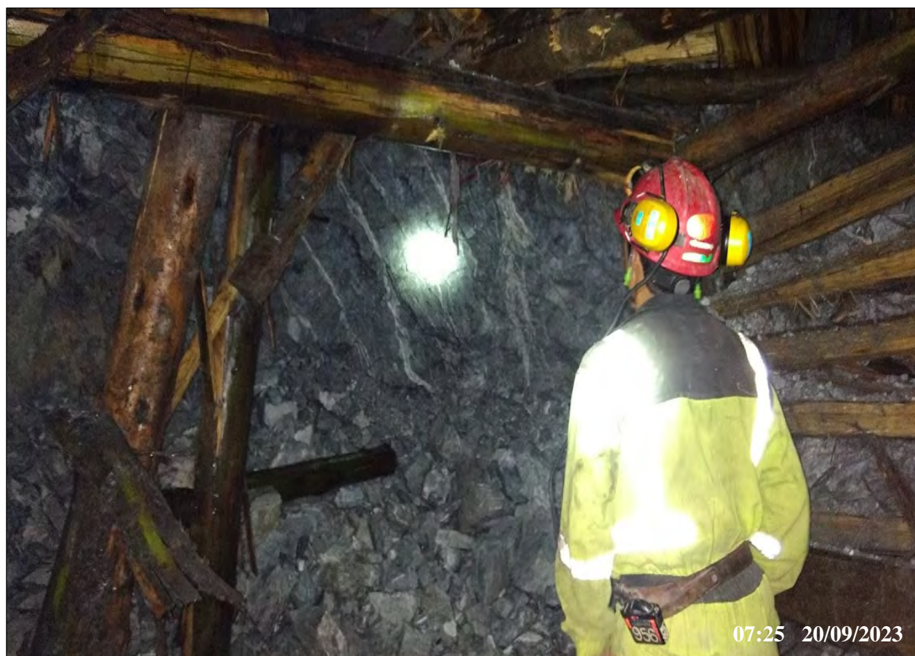
Figura 2. Evaluación del macizo rocoso después de la voladura
