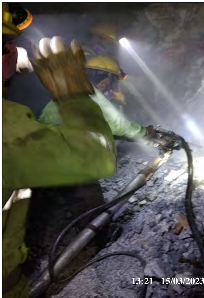
Figura 24. Perforación de los taladros de arrastre de la GL755 SO
