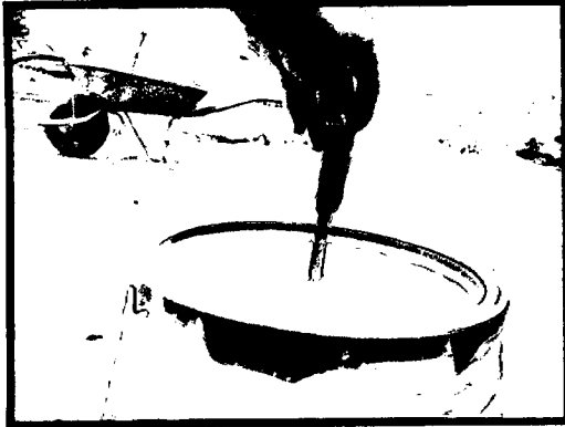
Apertura de tapa del biodigestor.
