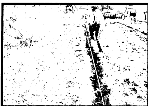
Medida del terreno con cordel.
