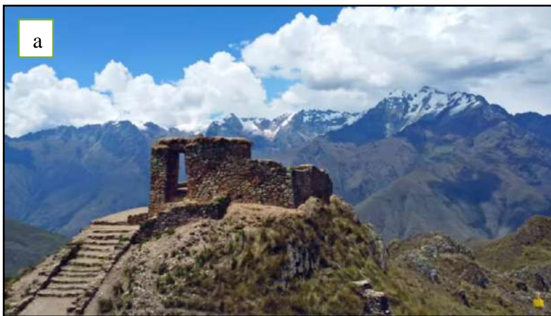
a: La puerta del sol o Geomirador Inti Punku, facha principal
