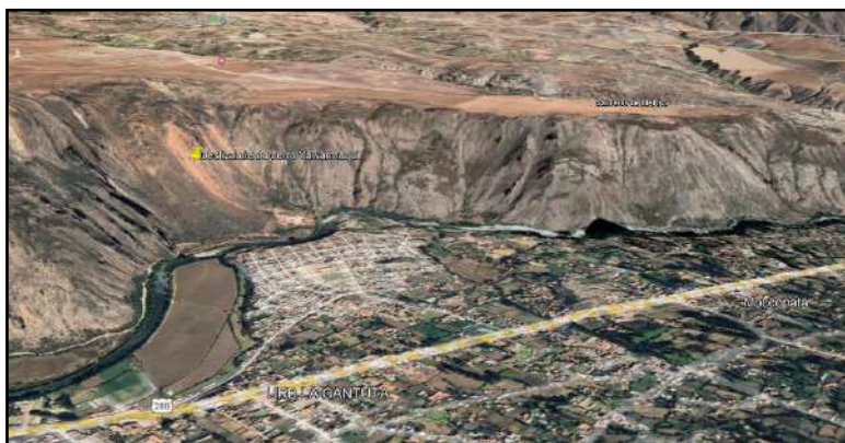
Figura 95: Vista hacia el SO del Geositio Deslizamiento del Cerro Yawarmaqui en Urubamba
