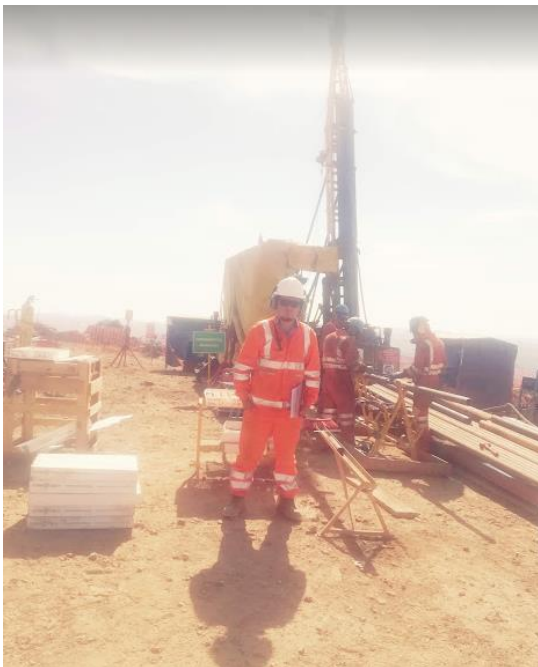
Fotografía N° 06: Control de perforaciones geotécnicas
