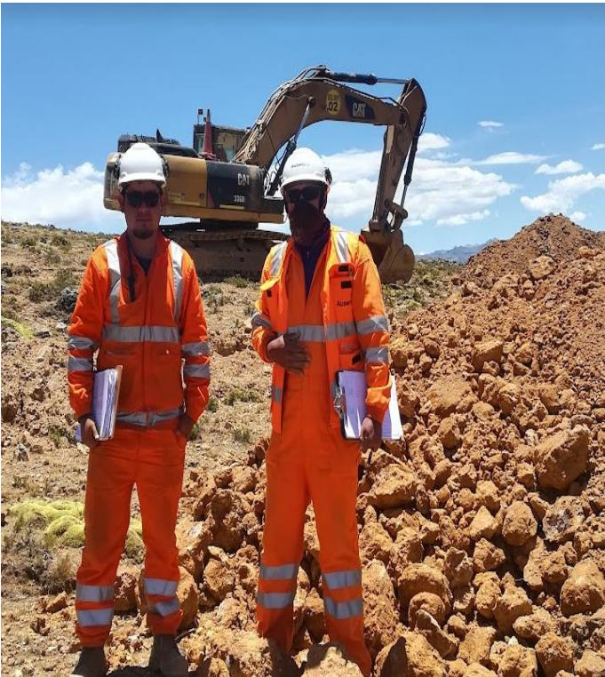
Fotografía N° 02: Verificación de excavación de calicatas
