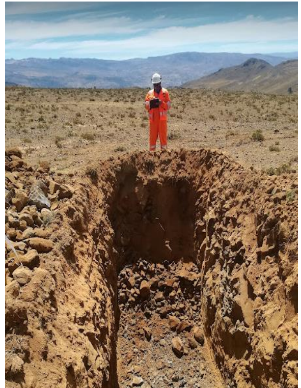
Fotografía N° 03: Control de excavación de calicatas
