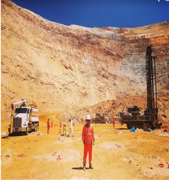
Fotografía N° 08: Mapeo geotécnico post perforaciones para colocación de materia explosivo
