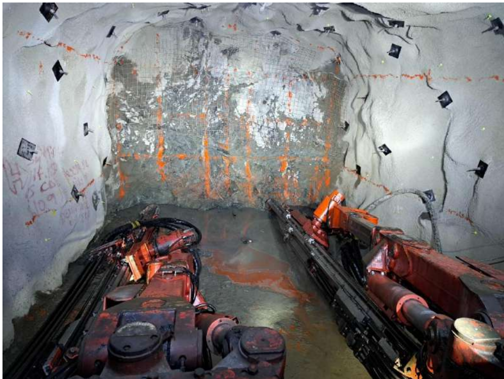
Figura 6. Equipo Jumbo J-30 en perforación
