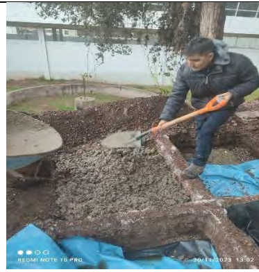
Vaciado losas de concreto permeable
