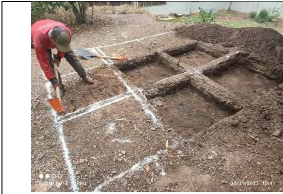
Excavación de zanjas para las losas de concreto permeable
