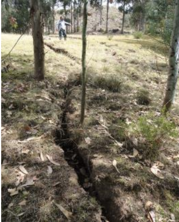
Figura 25: Escarpe de deslizamiento en pendiente fuerte
