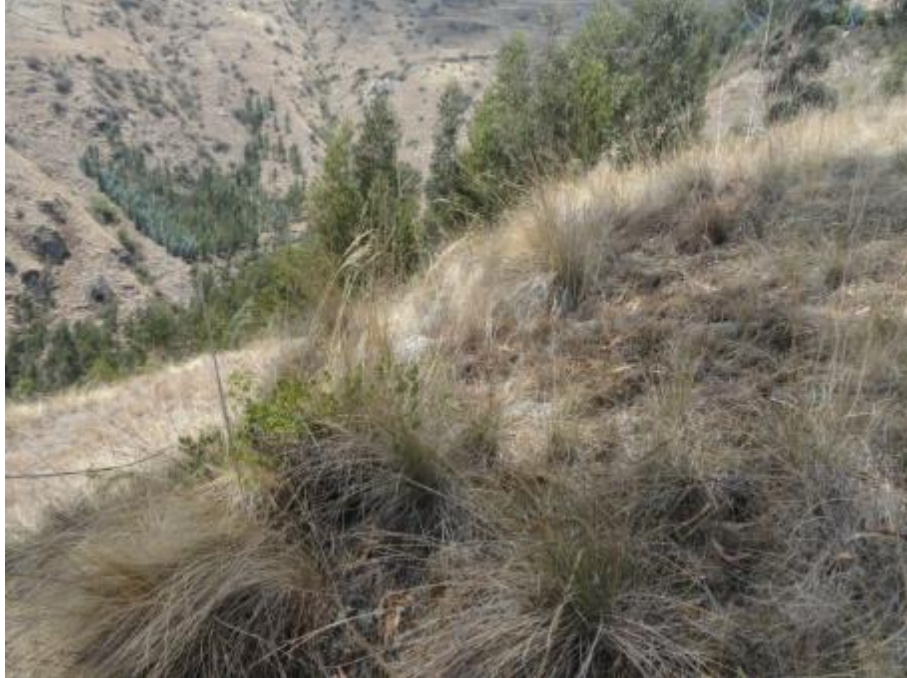
Figura 37: Quebradas pequeñas dentro del cuerpo de deslizamiento susceptibles a la erosión.
