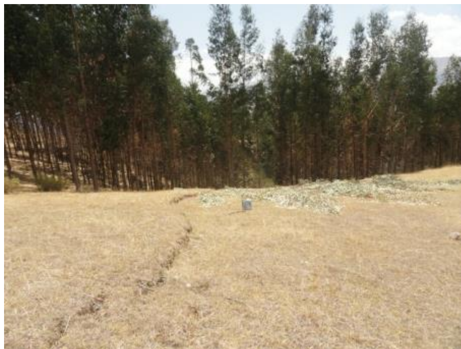
Figura 23: Escarpa de deslizamiento en afloramiento rocoso altamente fracturado e intemperizado
