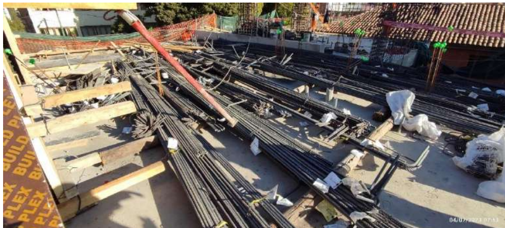
Descarga de acero dimensionado
