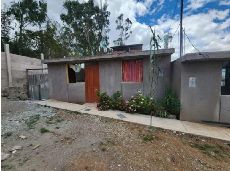
Fotografía 05. Viviendas construidas gracias a Techo Propio
