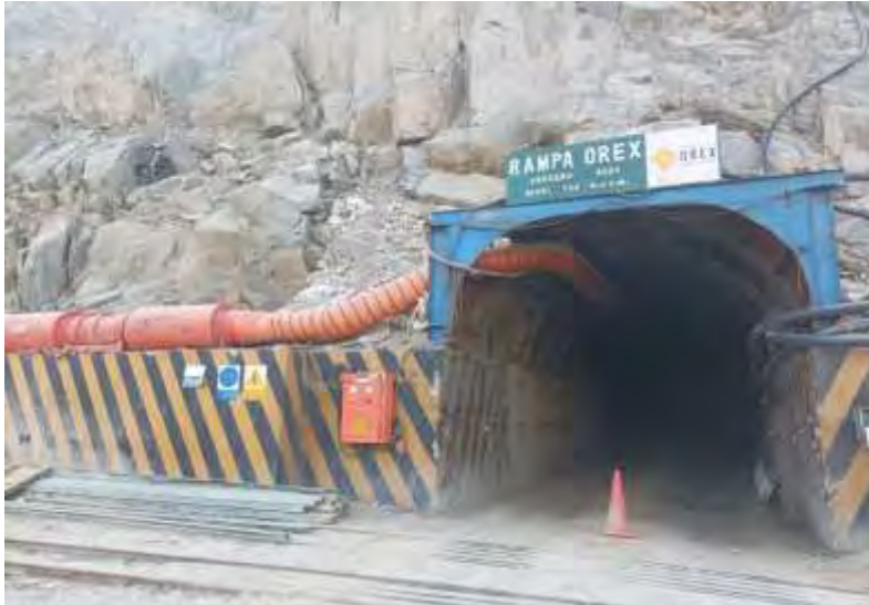
Bocamina Rampa (-)8524-foto
