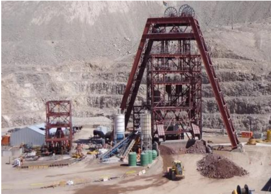
Figura N°8. Construcción de Pique
