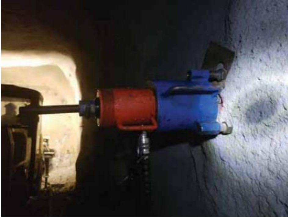
Figura N°14. Foto de Pruebas de arranque de pernos Helicoidales
