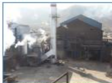
Vista panorámica de la planta industrial
