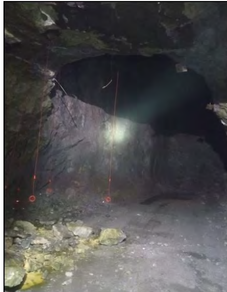
Figura 18. Voladura de taladros paralelos y taladros abanicos
