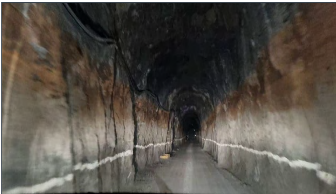
Figura 33. Verificación y acondicionamiento de la labor
