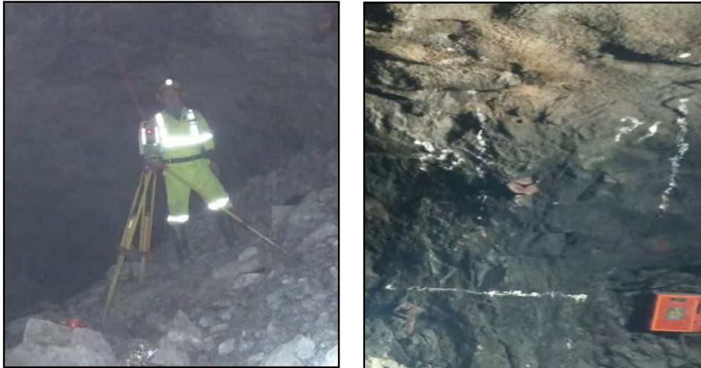
Figura 35. Pintado de malla de perforación.
