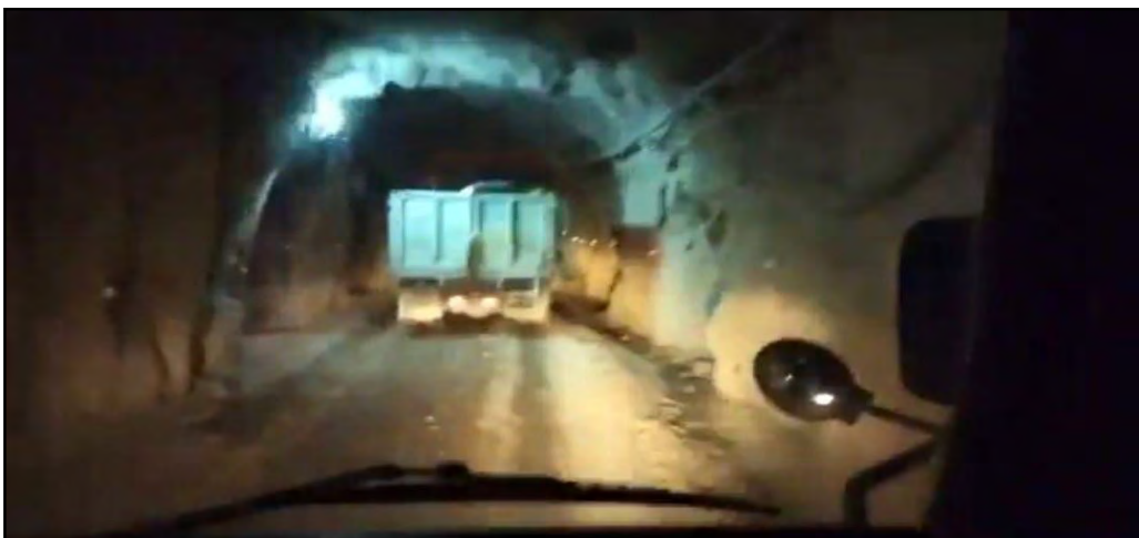
Figura 37. Ingreso y salida de personal
