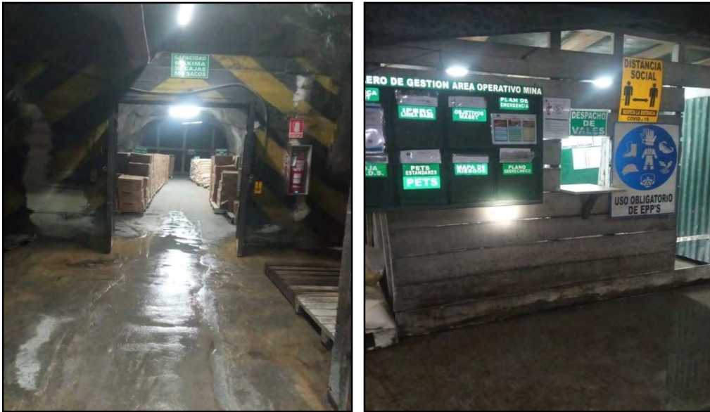
Figura 43. Polvorín en interior mina
