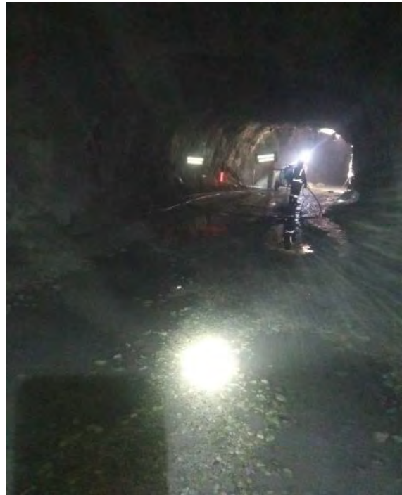
Figura 16. Voladura de taladros largos
