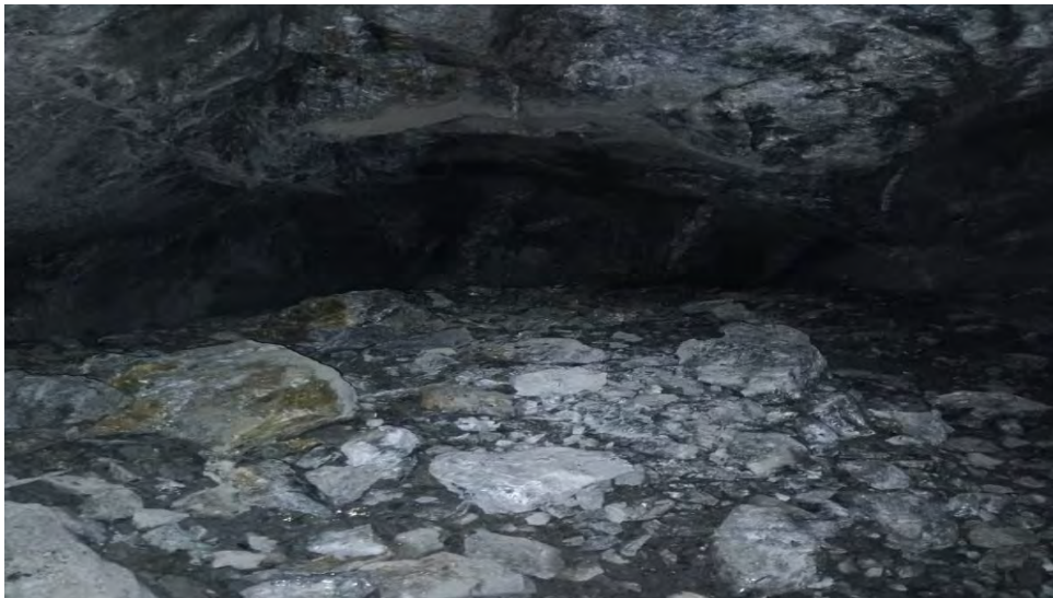
Voladura de frente (Galería 335)
