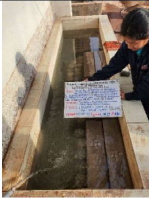
Curado de concreto
