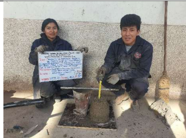
Medición del asentamiento del hormigón con el cono Abrams
