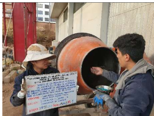
Colocación de PAA en la mezcla de concreto
