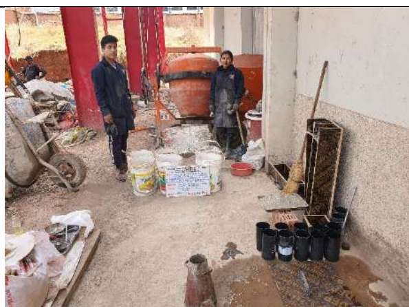
Preparación de mezcla de concreto
