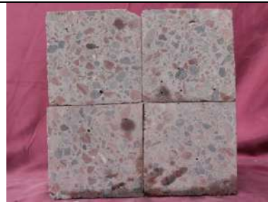
Corte de vigas con adición de 2.5%PAA
