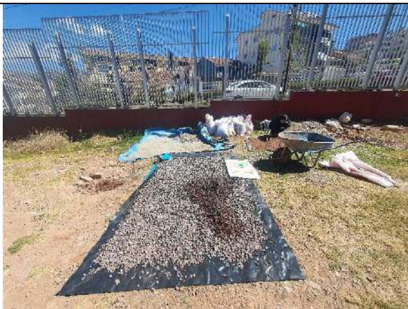
Adquisición de agregado grueso
