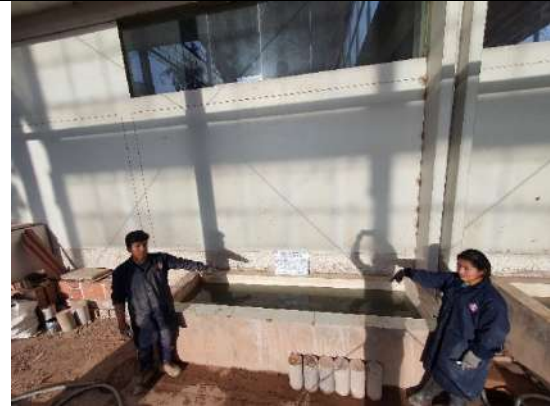
Curado de concreto
