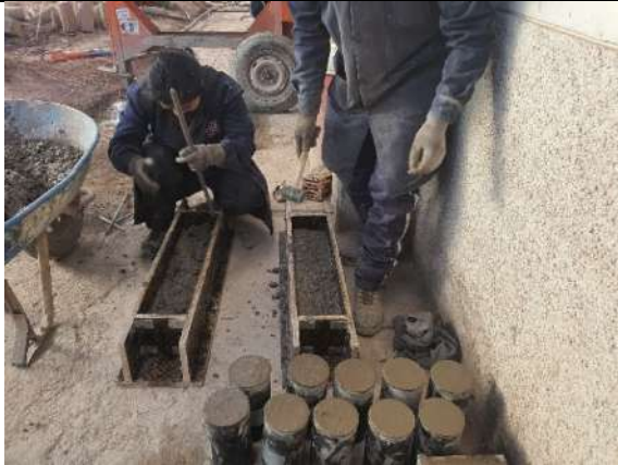
Colocado de concreto en moldes en moldes para viga
