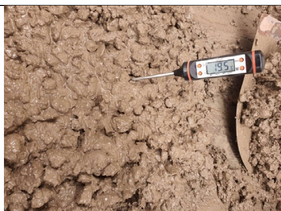
Temperatura de concreto
