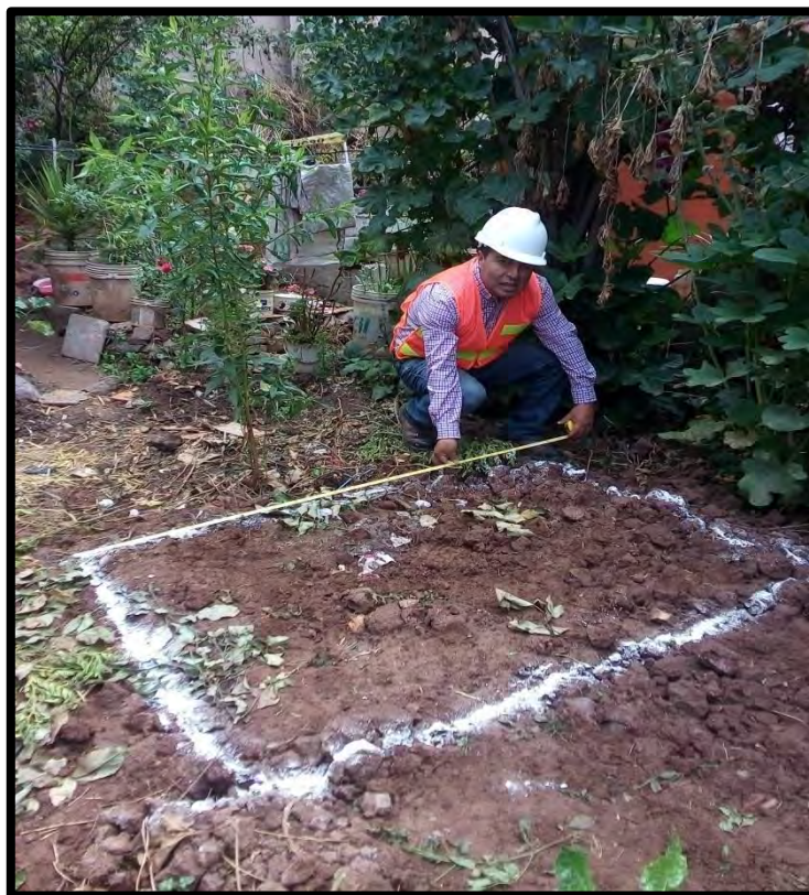
Gráfico 13.5: TRAZO Y REPLANTEO PARA POSTERIOR EXCAVACIÓN DE LA CALICATA N° 2.
