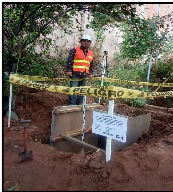
Gráfico 13.7: ENTIBADO Y PROTECCIÓN DE NUESTRA CALICATA N° 1.
