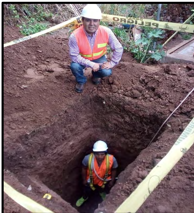
Gráfico 13.6: EXCAVACIÓN MANUAL DE LA CALICATA N° 2.
