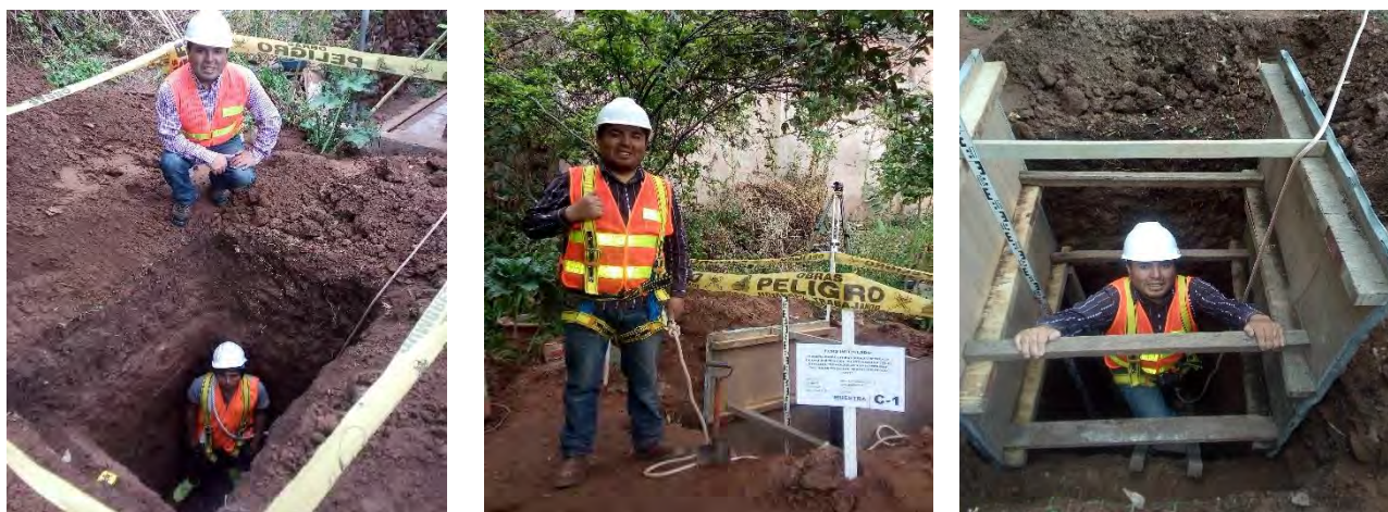
Gráfico 4.1: Medidas de seguridad del personal en excavación de zanjas.
