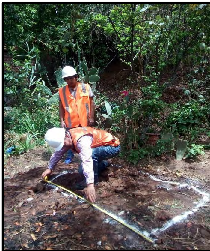
Gráfico 13.3: TRAZO Y REPLANTEO PARA POSTERIOR EXCAVACIÓN DE LA CALICATA N° 1.
