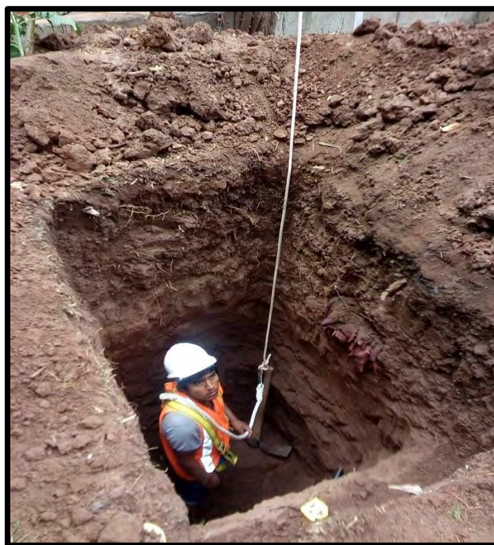
Gráfico 13.4: EXCAVACIÓN MANUAL DE LA CALICATA N° 1.
