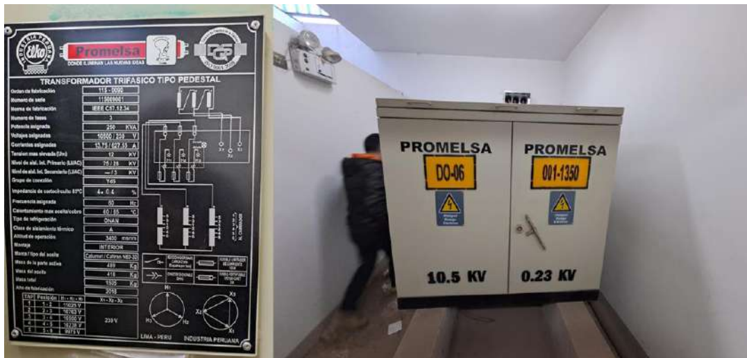
Fuente: Visita en Campo, Instalaciones de la S.E. de Ciencias Sociales.
