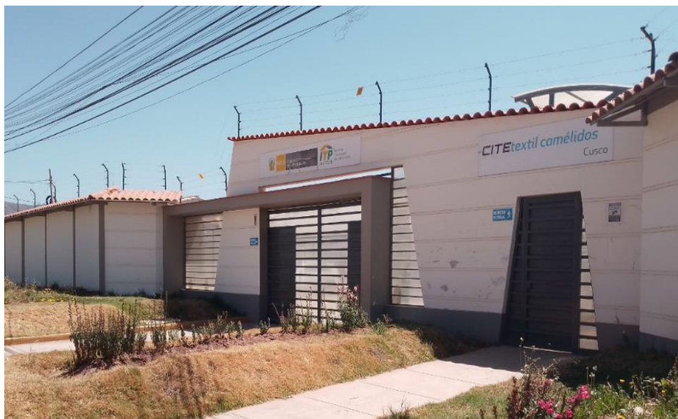
Figura 4. Vista fachada principal Fuente: Registro propio (2023)
