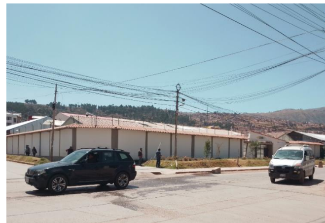
Figura 8. Vista del proyecto donde se aprecia su carácter hermético y poco participativo Fuente: Registro propio (2023)
