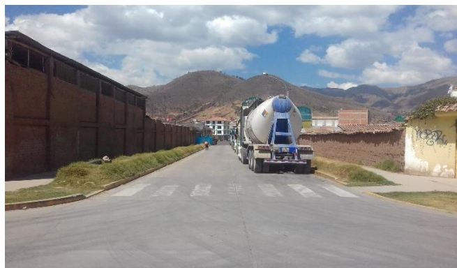
Figura 84. Acceso Av. República de Venezuela Fuente: Registro propio (2023)
