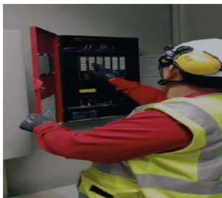
Fotografía 23. Inspección de panel del sistema contra incendio
