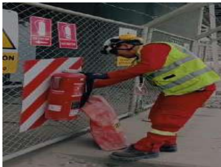
Fotografía 14. Inspección de extintores
