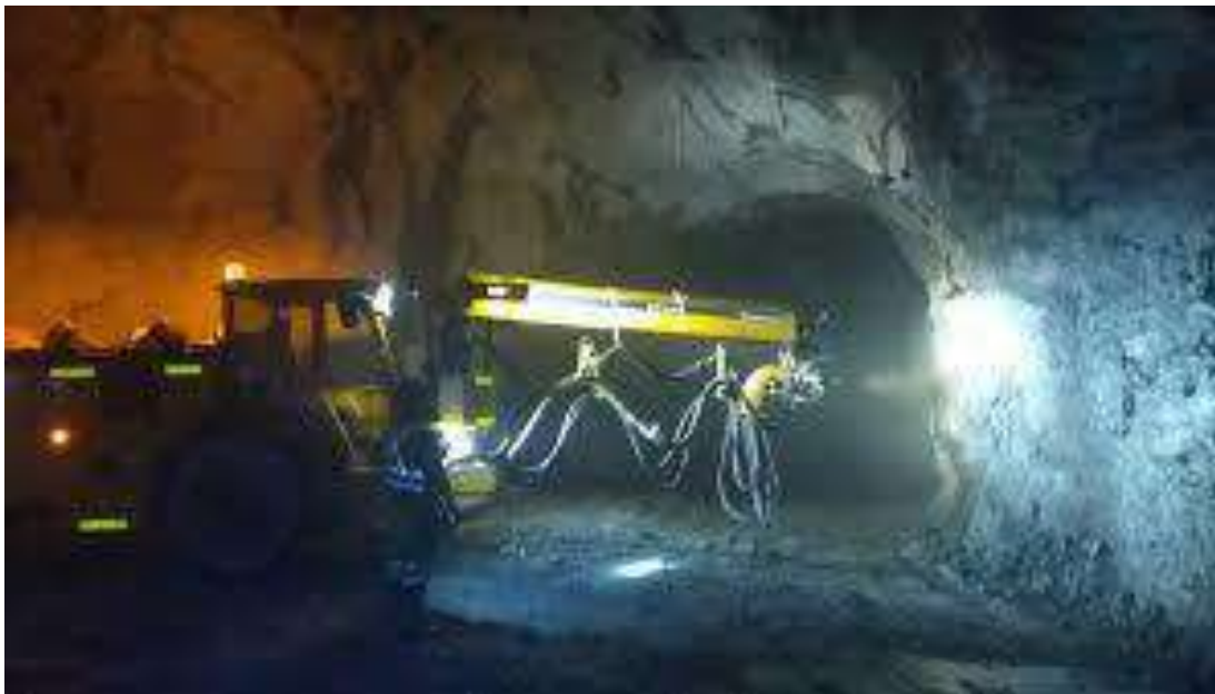
Figura N° 70 Lanzado de shotcrete vía húmeda con brazo robótico
