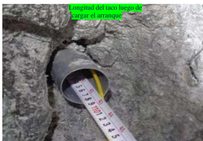
Figura N° 86 Longitud del taco luego de cargar al arranque
