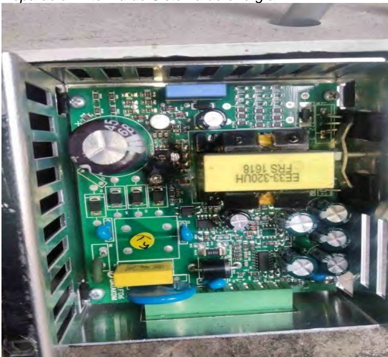
Figura 91 Reparación interina de Sistema de energía
