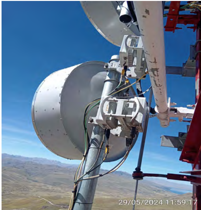
Verificación de la carcasa de la antena
