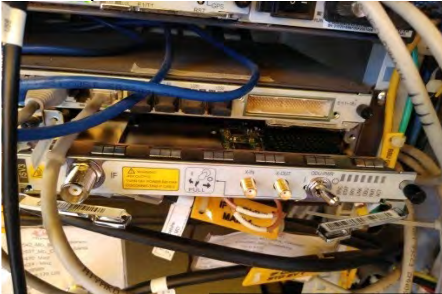
Figura 90 Cambio de tarjeta ISV3
