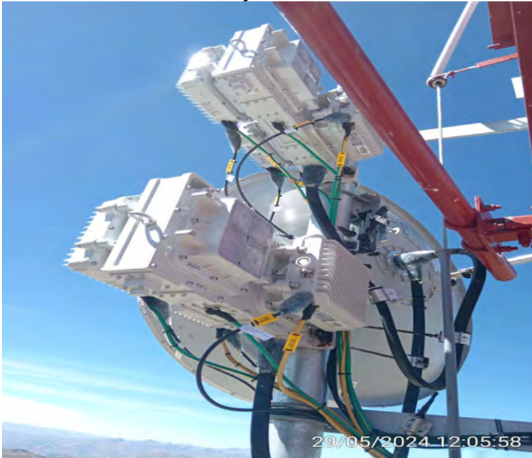
Figura 77 Verificación de conectores y vulcanizado
