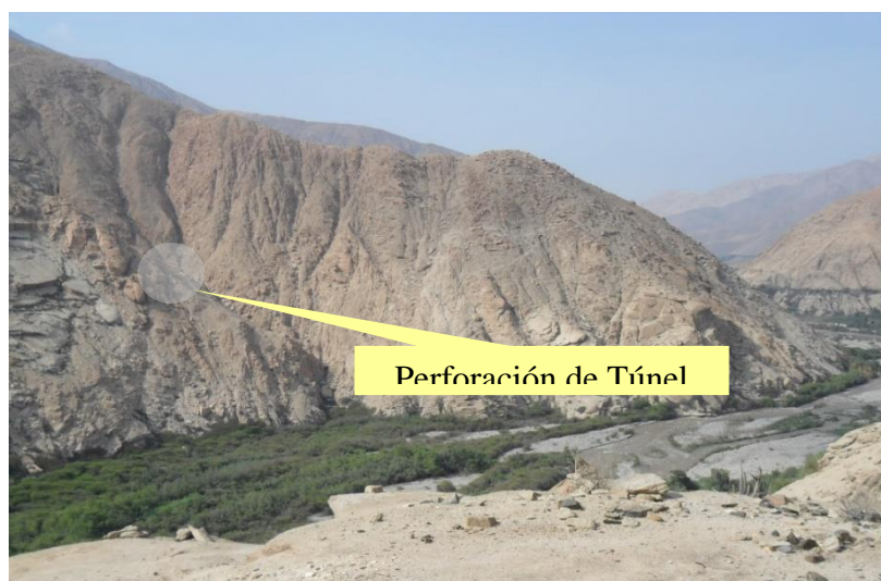
Figura 13. Lugar de perforación para túnel
