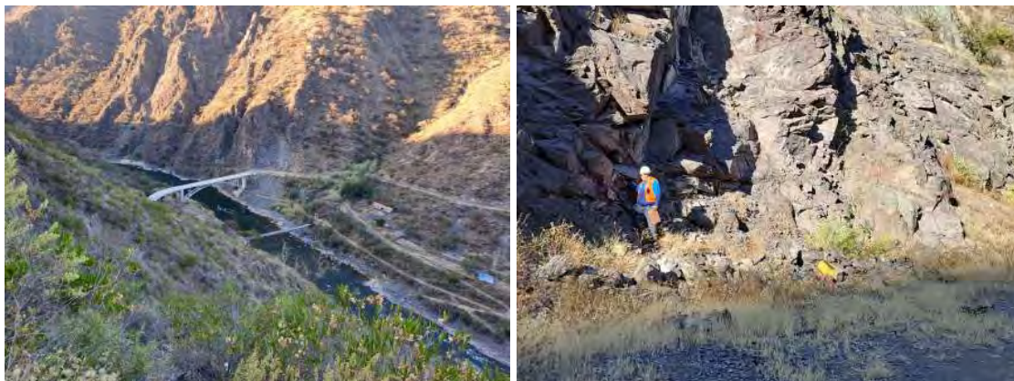
Foto 2: Vista final del tramo carretero en el sector de Pampahuata Prog. 45+901 Km colindante con el río Apurímac
