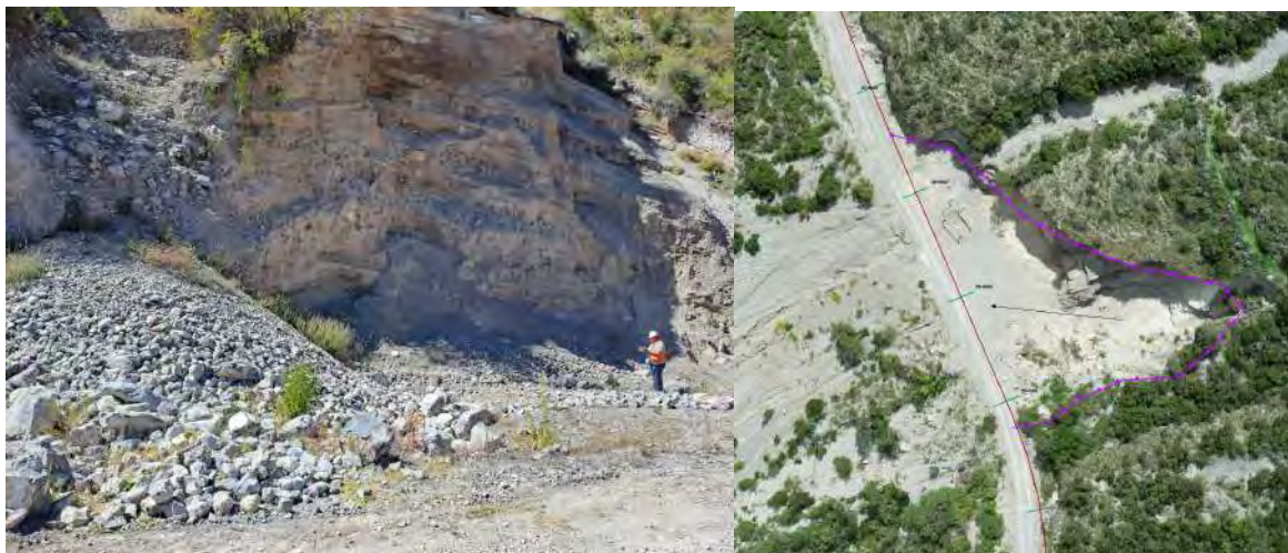
Foto 25: Vista del deslizamiento utilizado como cantera de agregado
