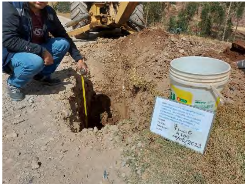
imagen 33: Calicata sobre Carpeta de Rodadura de Vía actual.
