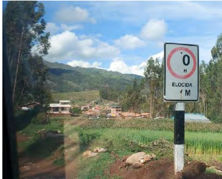
Imagen 41: Señal reglamentaria en mal estado.
