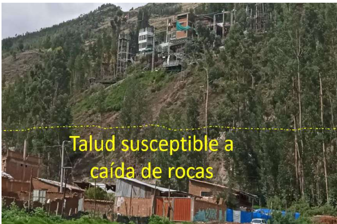
Figura. 62: Zona susceptible a caída de rocas
