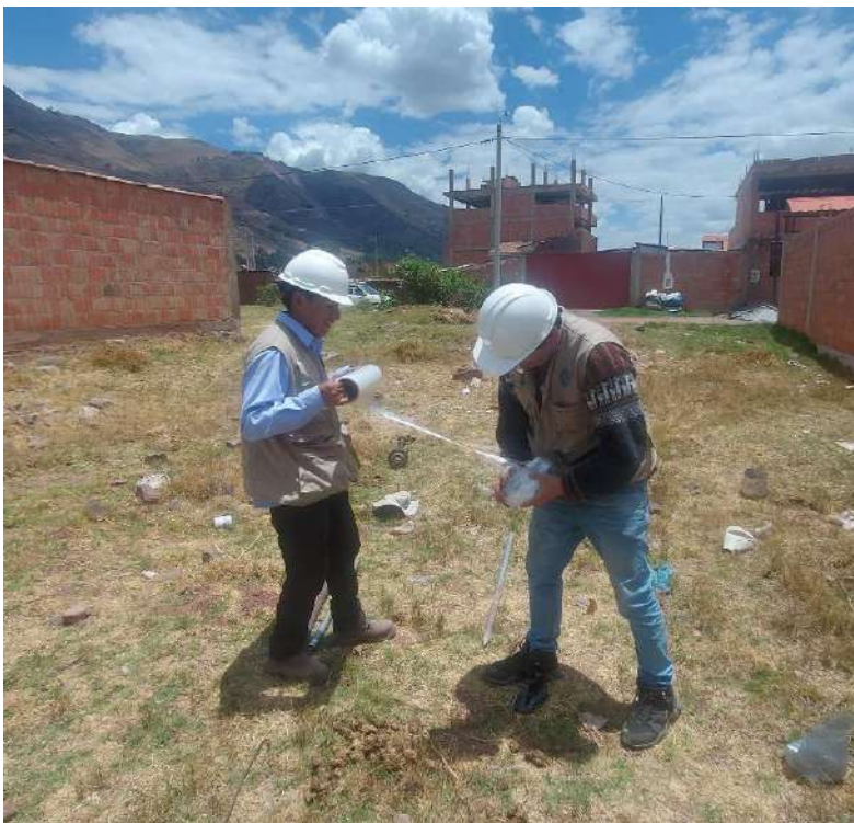
Figura. 74: Extracción y embalaje de muestra alterada en la zona de estudio
