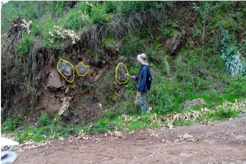
Figura. 57: Depósitos coluviales en corte de carretera
