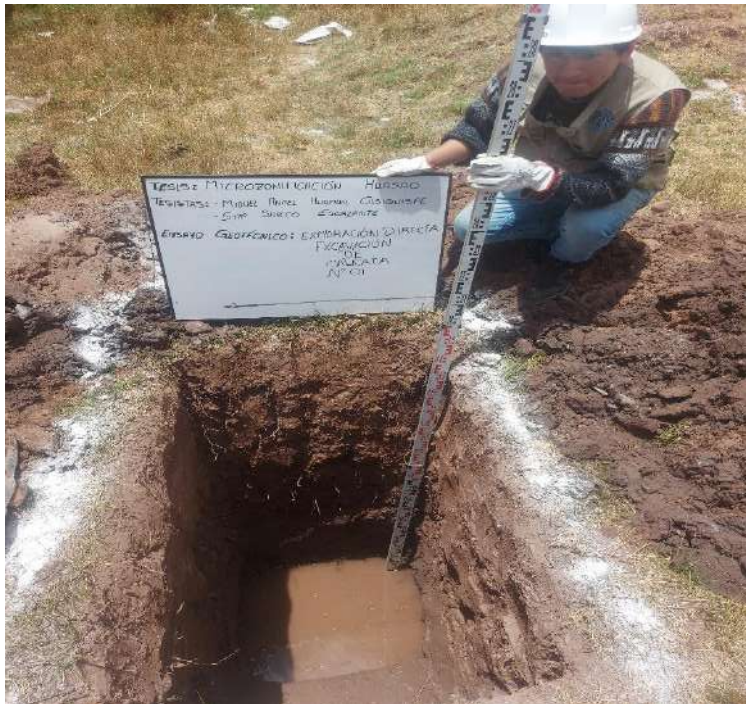
Figura. 68: Excavación de calicata con presencia de nivel freático
