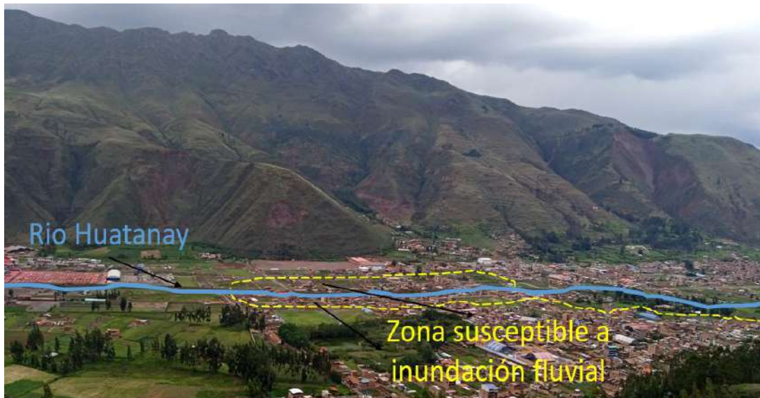
Figura. 65: Fenómeno de geodinámica externa en el centro poblado de Huasao
