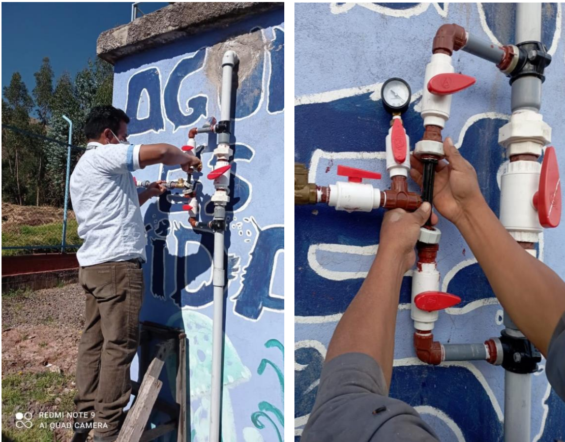
Foto 3 Instalación de Sistema Venturi
