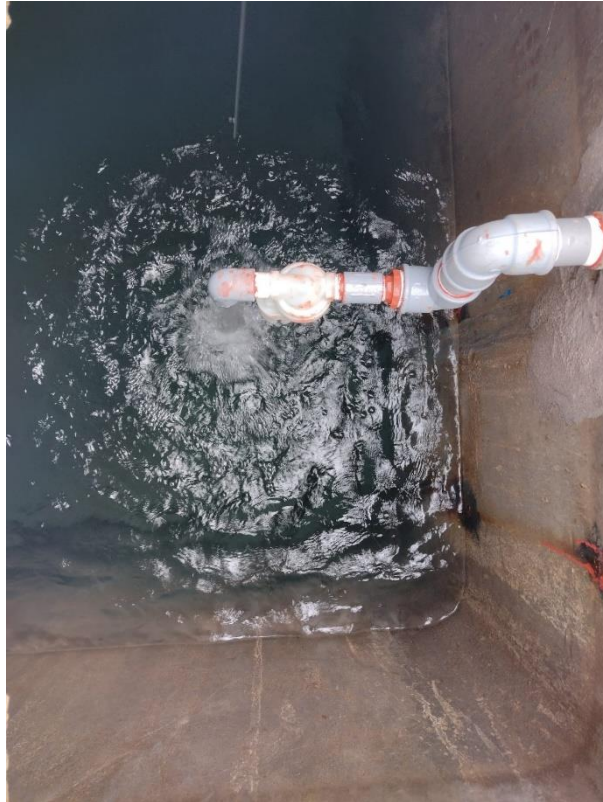
Foto 5 Entrada de agua a reservorio de comunidad de Tankarpata
