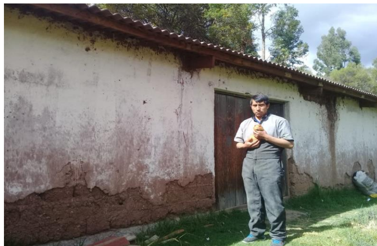
Imagen 6.- Instalación externa del galpón
