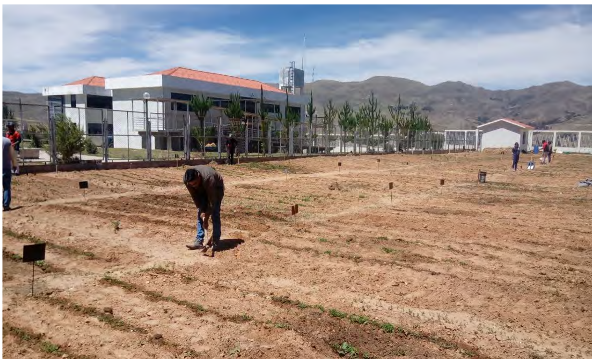
Fotografía 01. Marcado y preparación del terreno.
