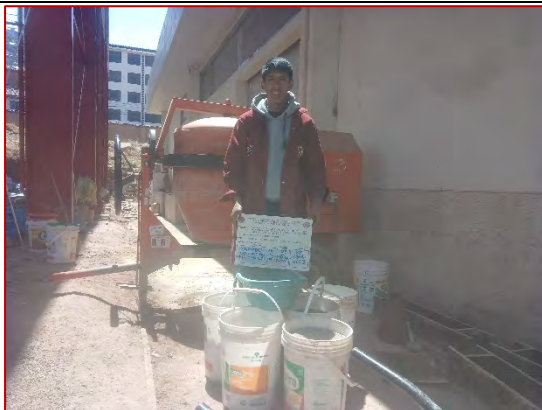
Componentes para la elaboración de 3 vigas de concreto patrón de f'c=210 \text{ kg/cm}^2 + 15% de adición de relave minero
