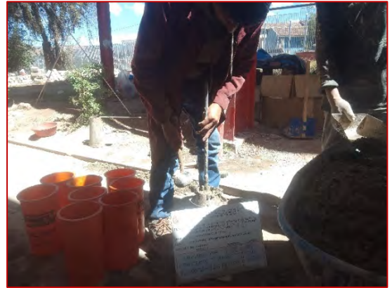
Ensayo de consistencia de la mezcla de concreto patrón f'c=210 \text{ kg/cm}^2 + 10% de adición de relave minero
