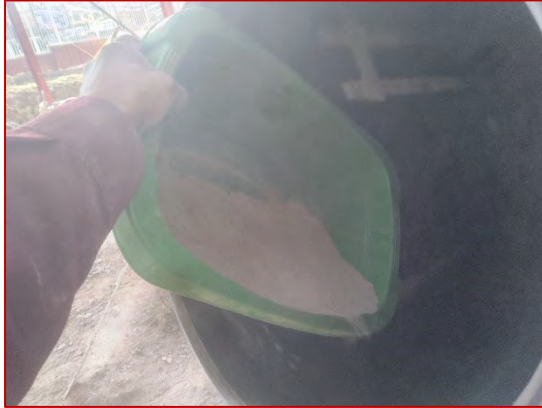
Adición de relave minero a la mezcla de concreto en un 10% del peso del material cementante
