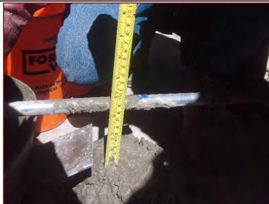
Medición de la consistencia de la mezcla de concreto patrón f'c=210 \text{ kg/cm}^2 + 10% de adición de relave minero
