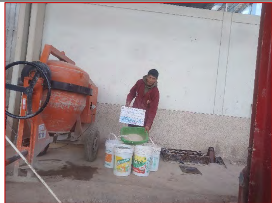
Componentes para la elaboración de 3 vigas de concreto patrón de f'c=210 \text{ kg/cm}^2 + 10% de adición de relave minero
