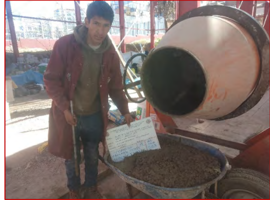
Mezcla de concreto patrón f'c=210 \text{ kg/cm}^2 + 5% de adición de relave minero
