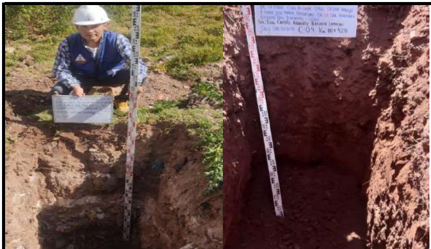
Imagen 4. Excavación de calicata para el estudio de suelos en la calle Ciro Alegria
