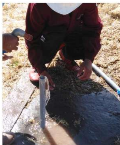
Colocado de codo y tubo
