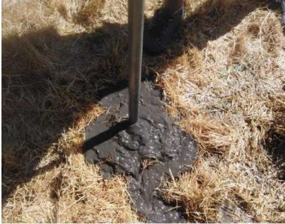
Inicio de perforación
