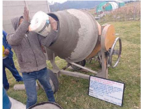
Añadir el agregado grueso y una parte del agua a la mezcladora.
