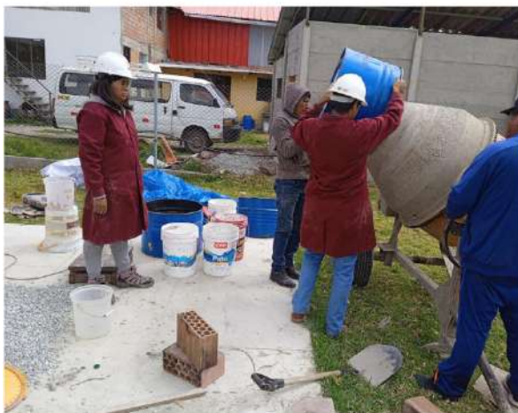
Añadir el agregado fino, el cemento y el resto de agua.
