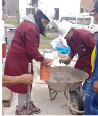
Llenado de las probetas con mezcla.
