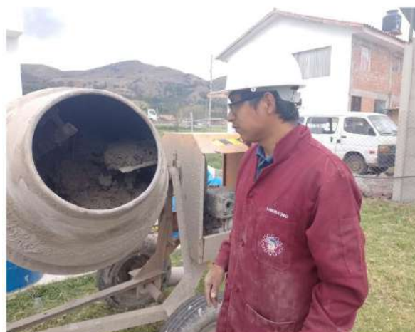
Inspección de la mezcla
