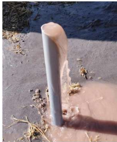
Cortar el tubo hasta una altura de 0.5m sobre la tierra
