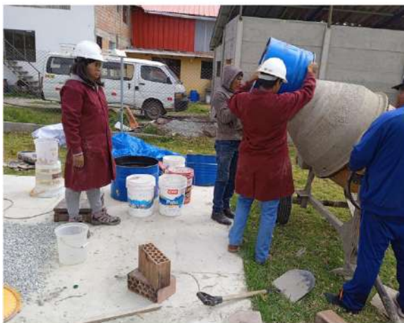
Añadir el agregado fino, el cemento y el resto de agua.
