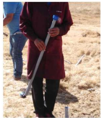
Cortar el tubo hasta una altura de 0.5m sobre la tierra
