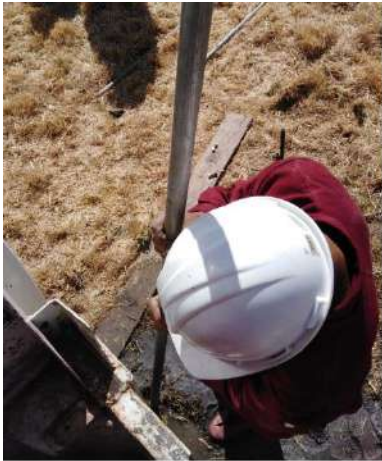
Extracción de tubo de acero
