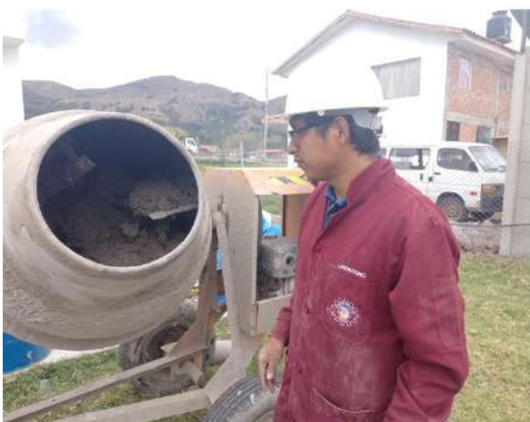
Inspección de la mezcla
