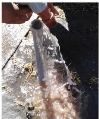
Colocado de codo y tubo
