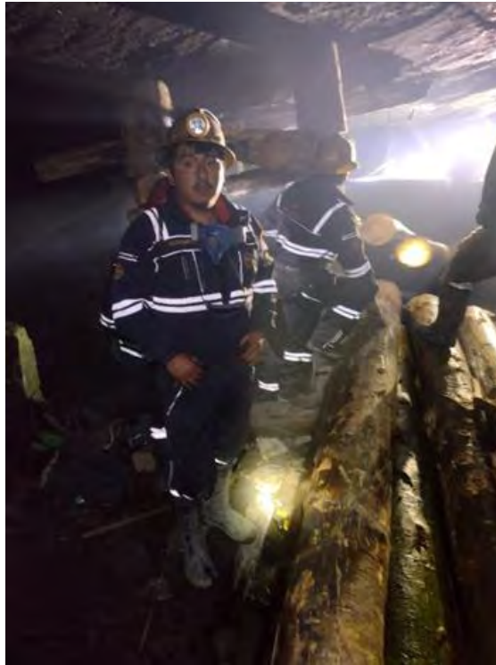
Fotografía que se aprecia la instalación de cuadros de sostenimiento
