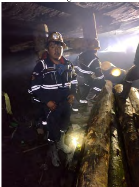
Figura 14: Sostenimiento de galería con cuadros de madera
