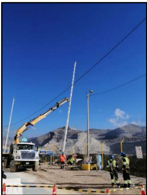
Fotografía 9. Montaje de Mástil metálico
