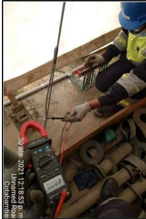
Fotografía 12. Medición de continuidad eléctrica
