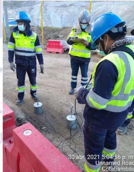
Medición de tensión de paso exteriores almacén
