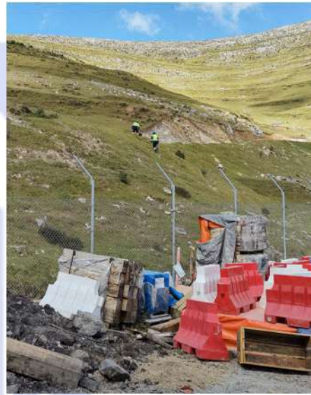
Ubicación de pica de inyección de corriente
