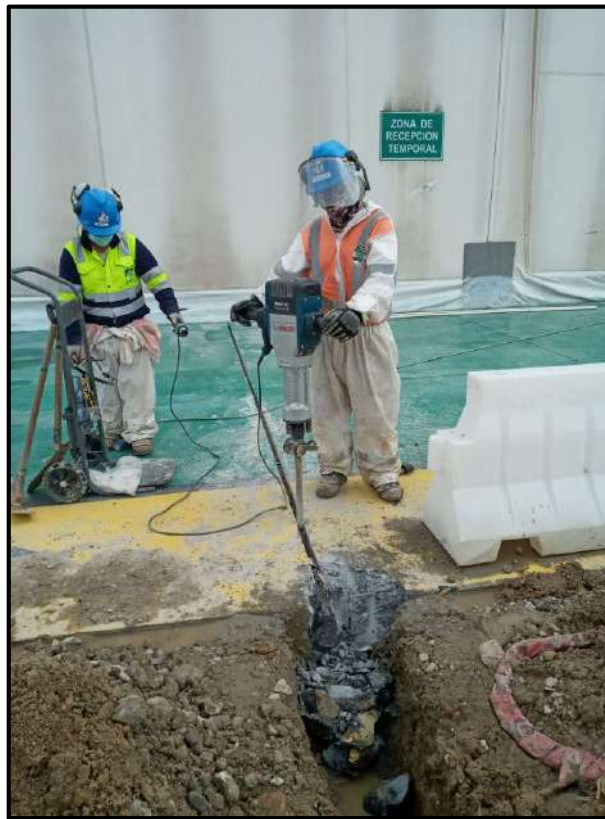
Fotografía 4. Demolición de losa para equipotencialización de acero de refuerzo
