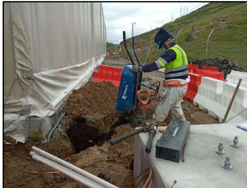
Fotografía 3. Construcción de Puesta a tierra
