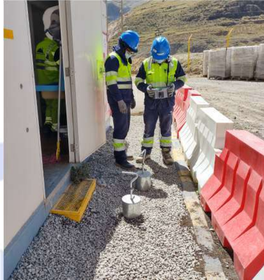
Medición de tensión de paso exteriores almacén
