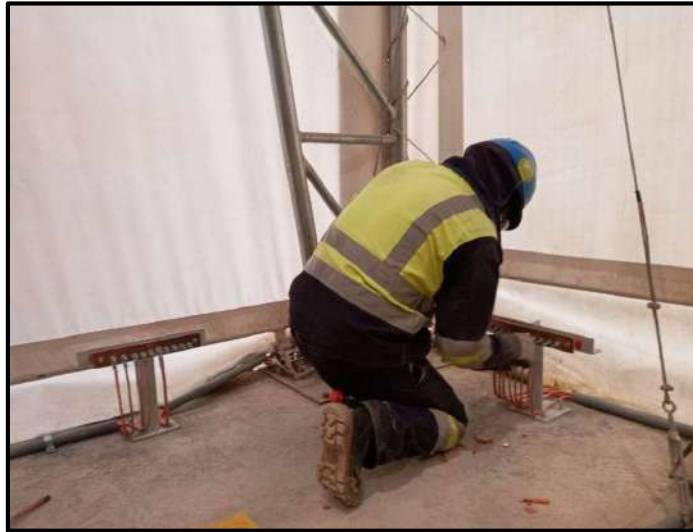
Fotografía 6. Instalación de barras de aterramiento para estructuras metálicas interiores
