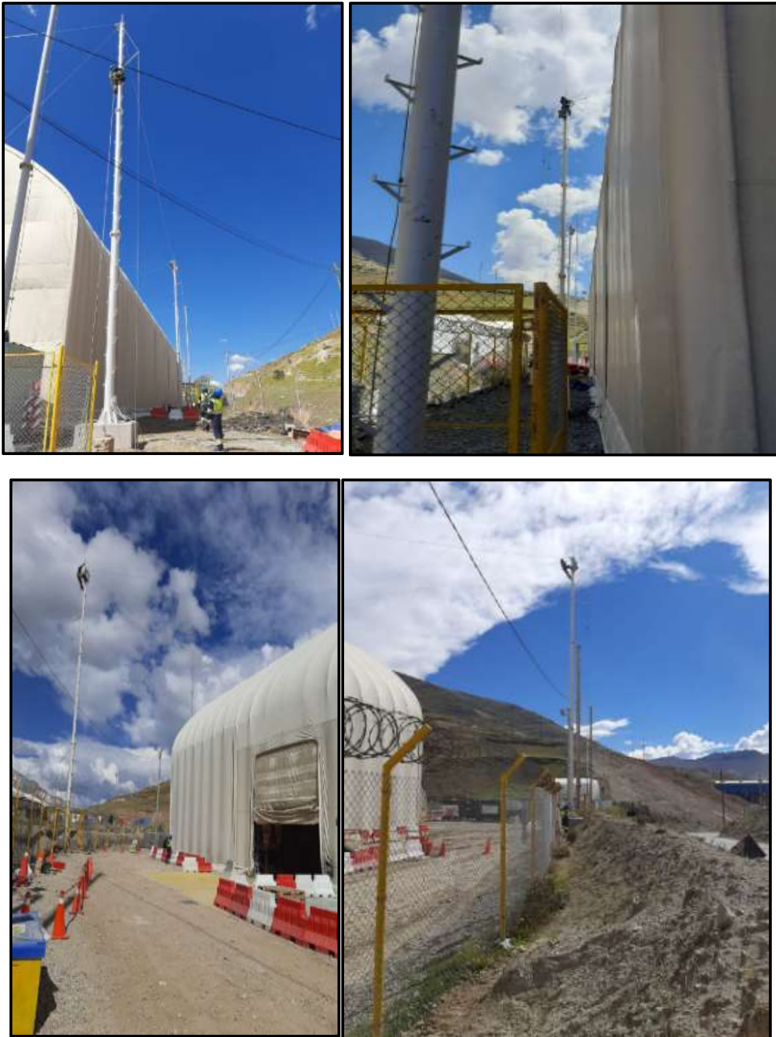
Fotografía 10. Instalación de sistema catenario
