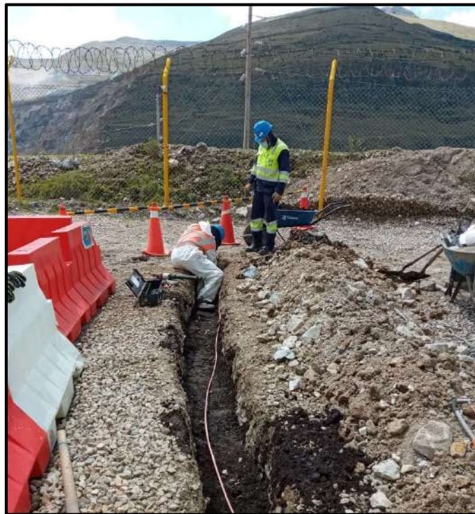
Fotografía 5. Construcción de malla a tierra 4/0 AWG
