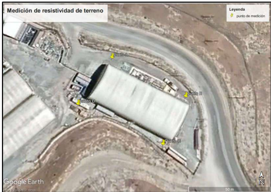
Figura 13. Puntos de medición de resistividad de terreno almacén mina
