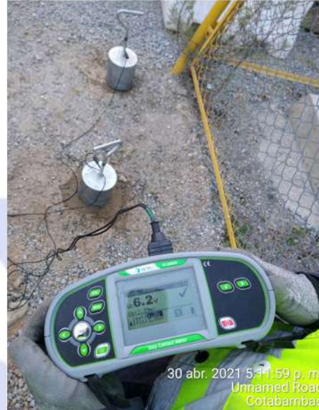
Medición de tensión de paso exteriores almacén
