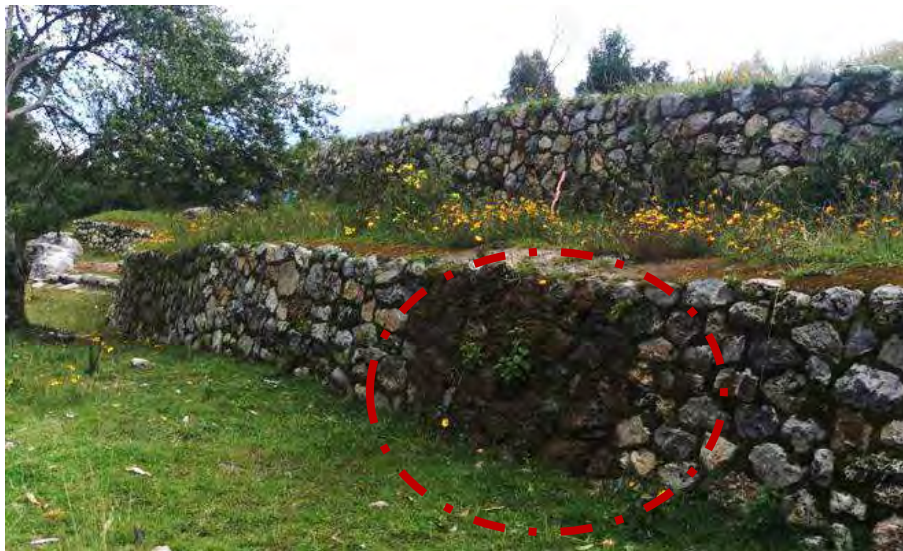
Figura 185. Canalización del agua de Ucucuchayoq, que discurren en el Sector de los andenes.
