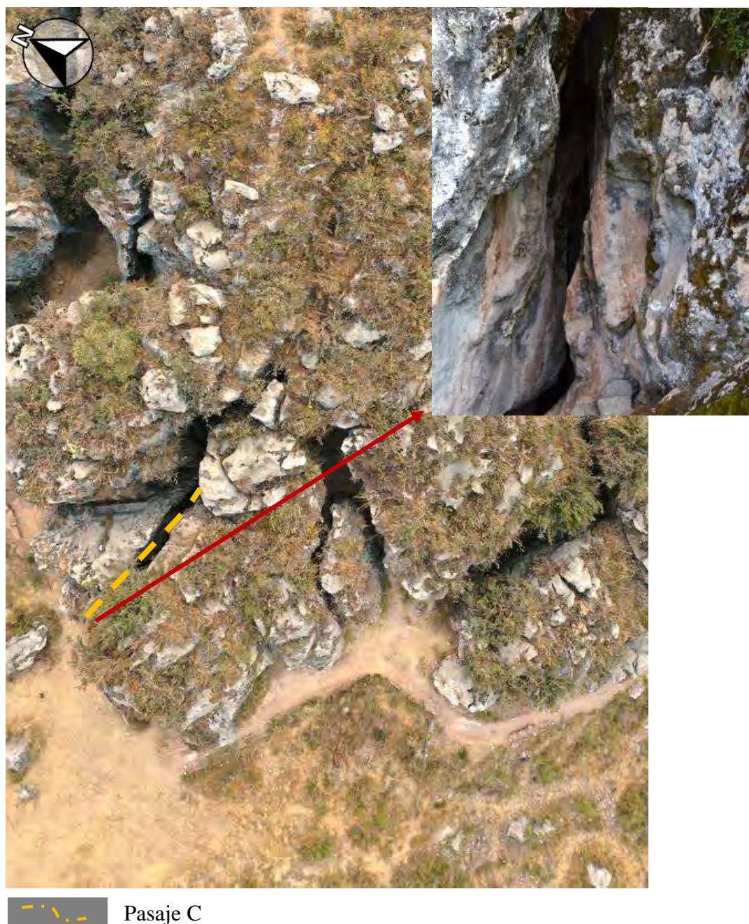
Figura 35. Ubicación del pasaje C. y detalle del acceso principal que da la forma del elemento escalonado, tallado en la parte superior.
