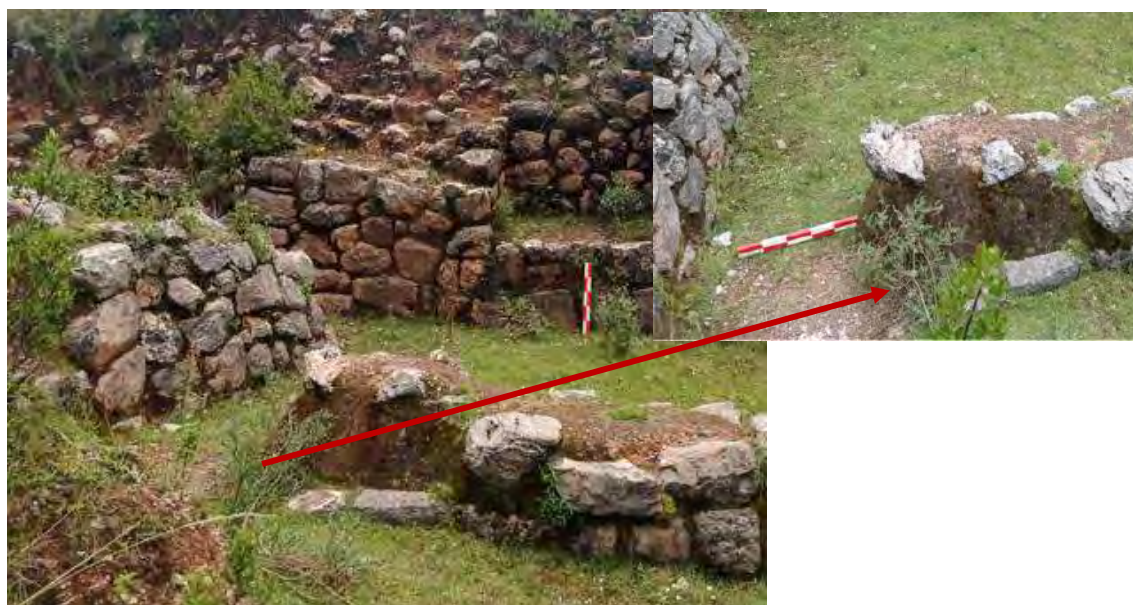
Figura 131. Vano de acceso.
