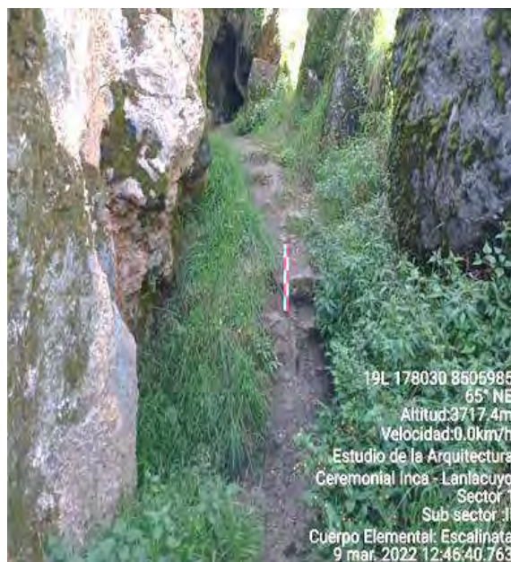
Figura 111. Escalinata interna con elementos líticos.
