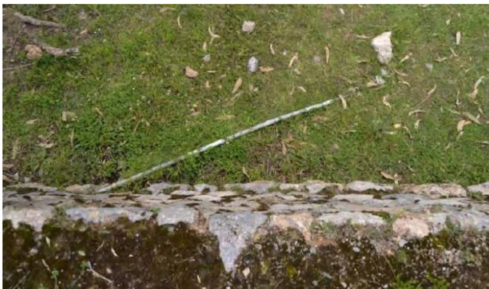
Figura 153. Detalle del tuvo en la plataforma del andén 1.
