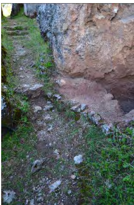
Figura 180. Muro de delimitación dentro del pasaje L.
