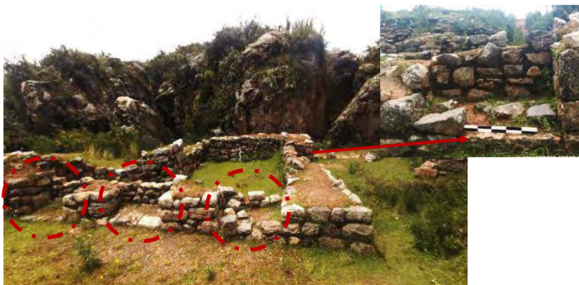
Figura 137. Conjunto de nichos trapezoidales del recinto 3.
