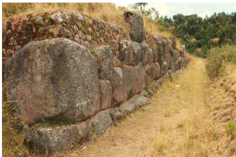
Figura 141. Muro de trazo lineal, de aparejo ciclópeo característico de la arquitectura monumental.
