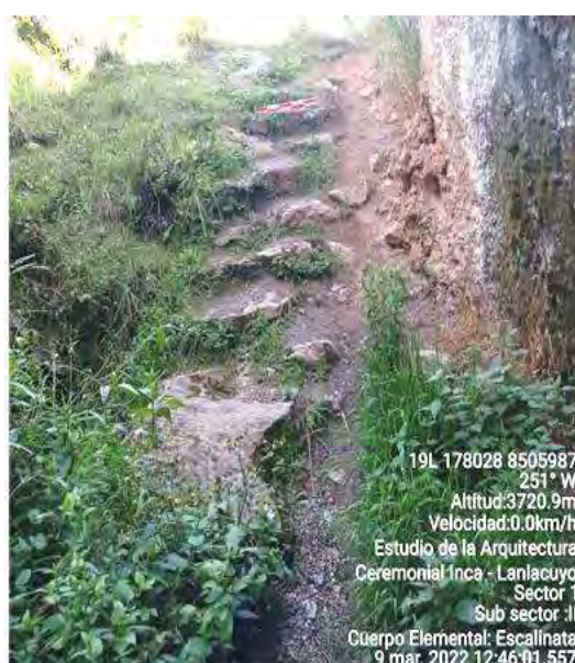
Figura 110. Escalinata interna con elementos líticos.
