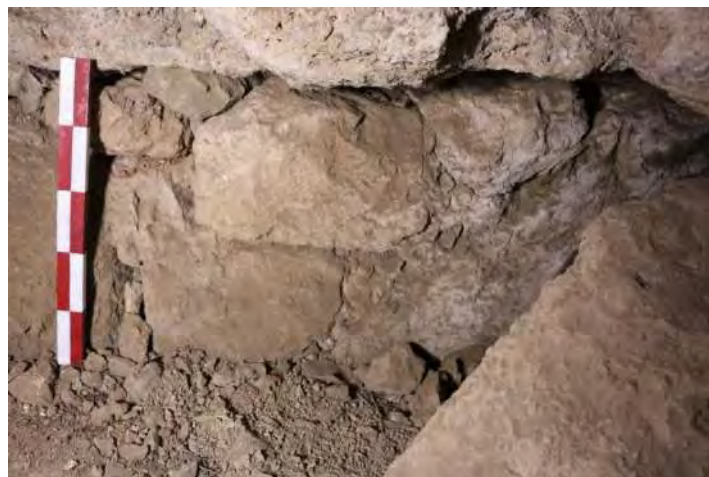
Figura 45. Evidencia del muro de delimitación al interior del pasaje E.
