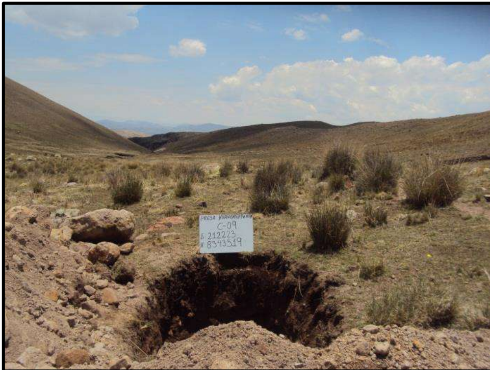
Foto 44: Calicata de vaso de presa
