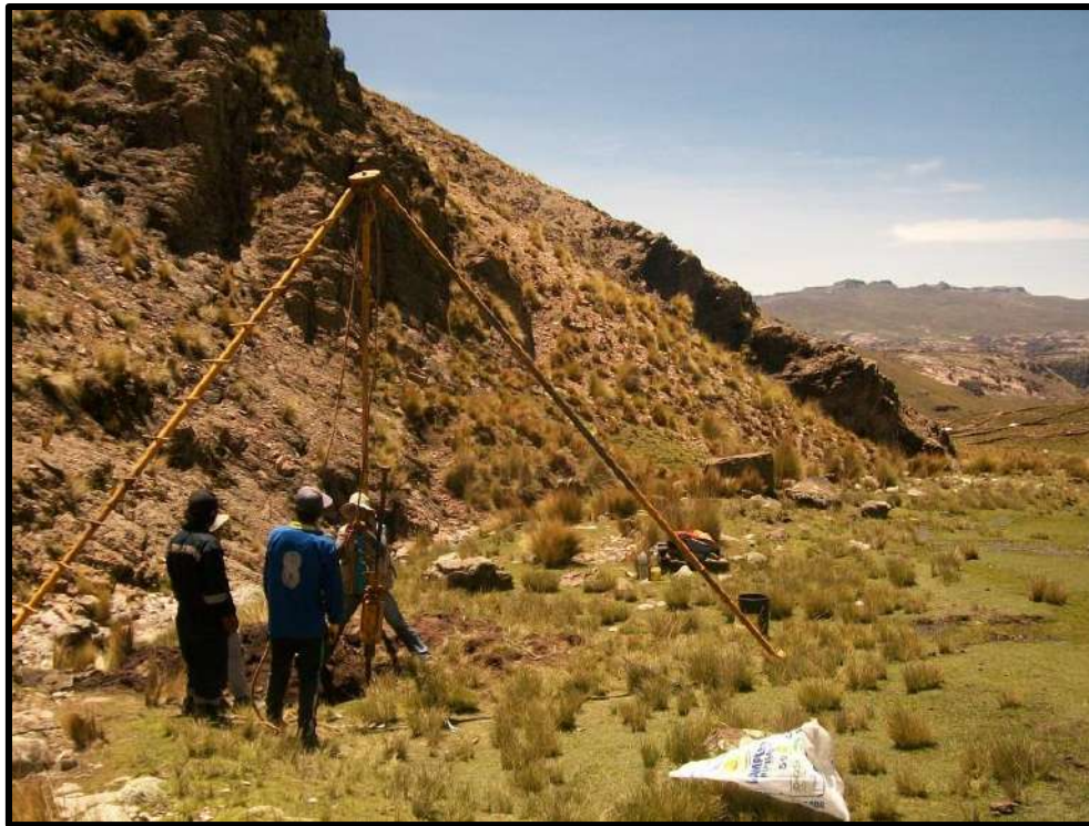
Cuadro 49: Ensayo de penetración dinámica tipo cono peck en la bocatoma Chillutira
