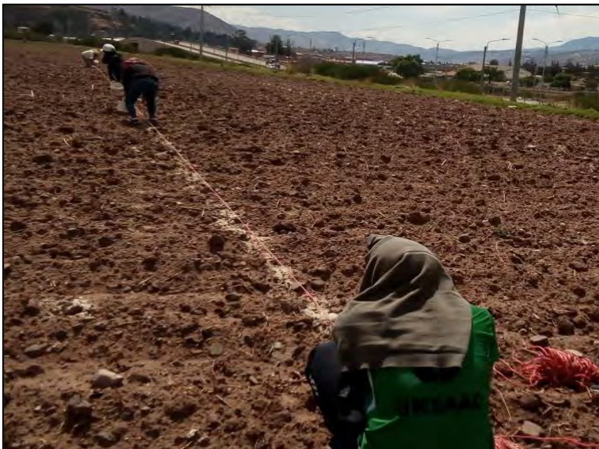
Figura 12: Replanteo del terreno
