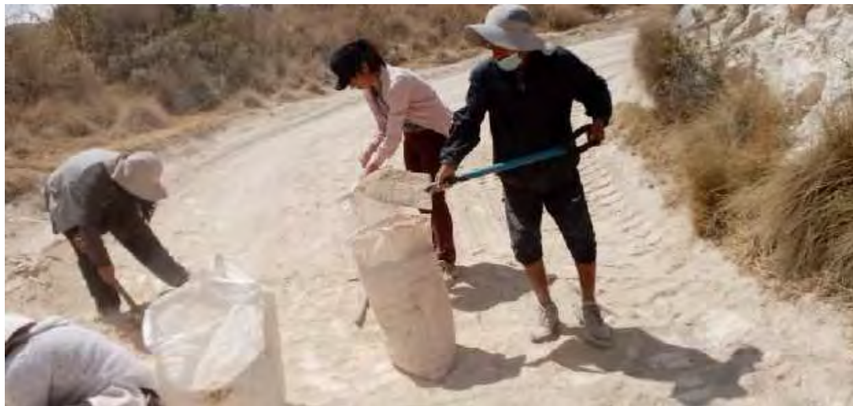
Foto 3. Preparación de la diatomea para el replanteo
