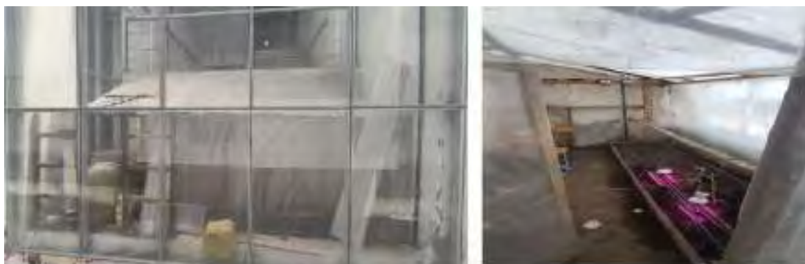
a) Vista exterior
