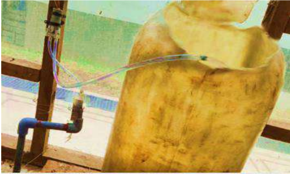
Figura 3.78 Ubicación de la mini bomba de agua
