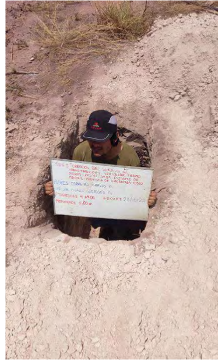
Fotografía 6-6: Calicata N° 06 Km: 4+400
