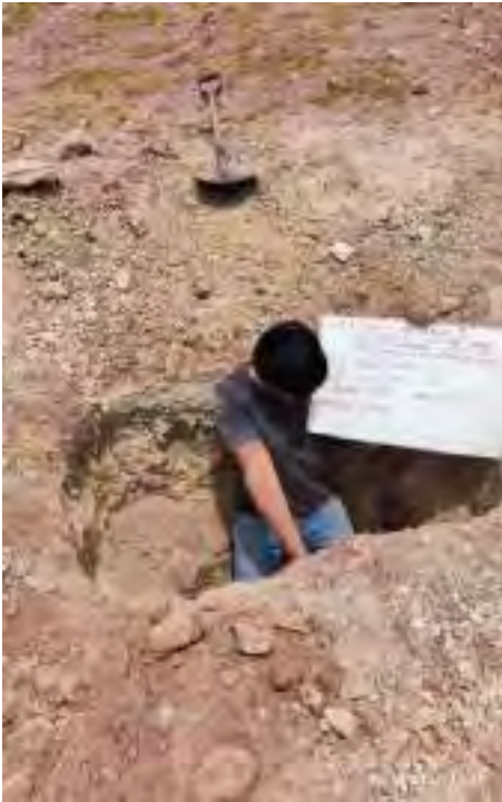
Fotografía 6-1: Calicata N° 01 Km: 0+300
