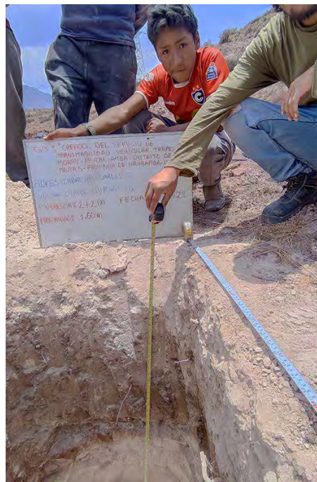
Fotografía 6-4: Calicata N° 04 Km: 2+200
