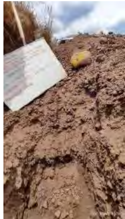
Fotografía 6-8: Calicata N° 08 Km: 5+850
