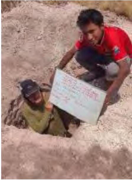
Fotografía 6-9: Calicata N° 09 Km: 6+200
