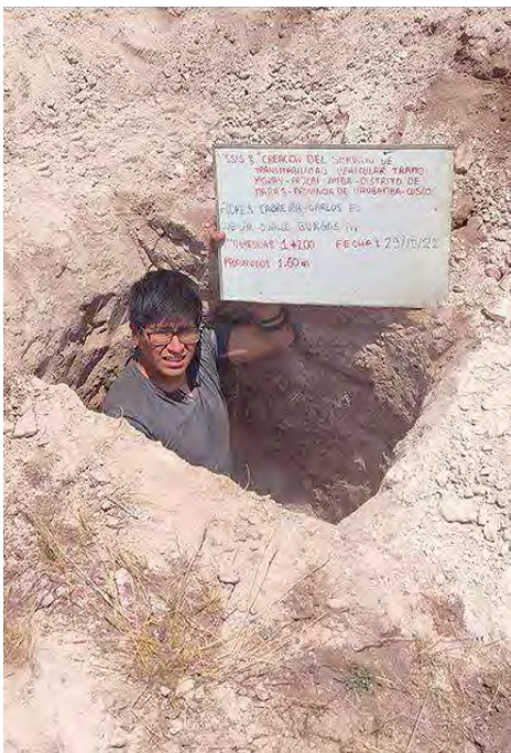
Fotografía 6-3: Calicata N° 03 Km: 1+200
