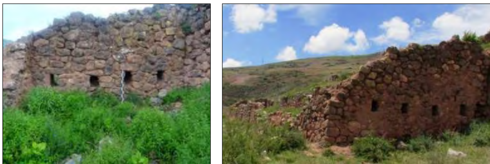
Nota. Depósito C17 del Sub Sector “C” – Huaynaqolqa, ductos de ventilación. Elaboración propia.
