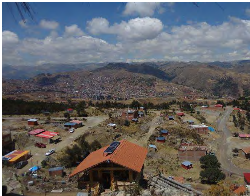
Uso de los paneles solares
