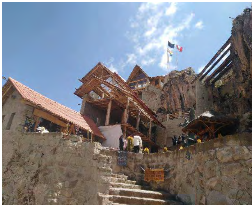
Acceso para el ingreso
