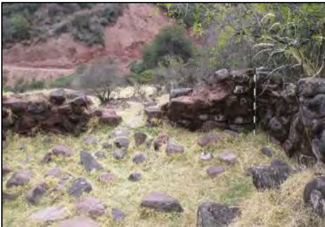
Nota: Interior del Recinto 1
