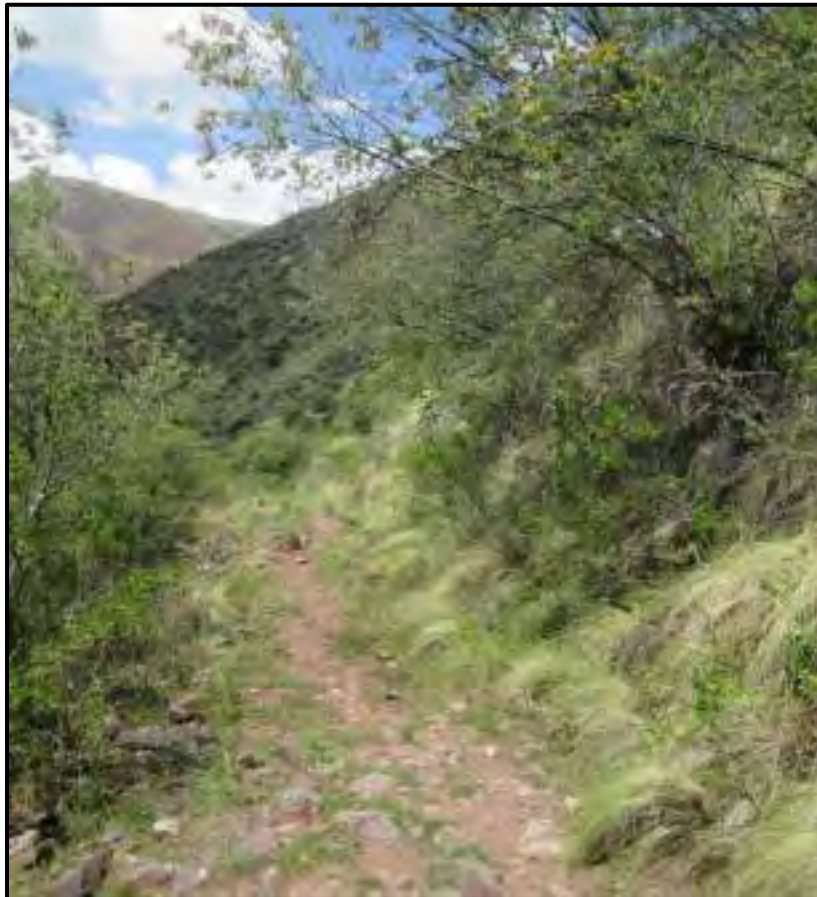
Nota: Calzada Elevada
