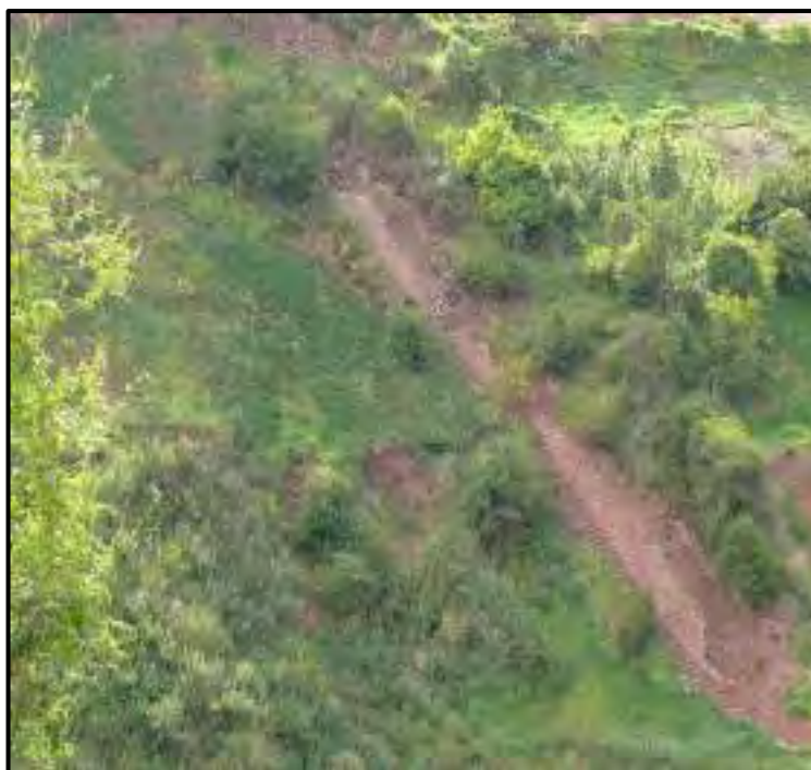
Nota: Muro de Contención del Anden
