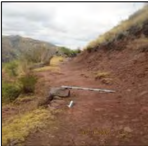
CAMINO CORTE TALUD
