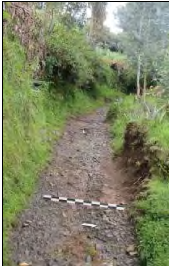
Nota: Camino Despejado
