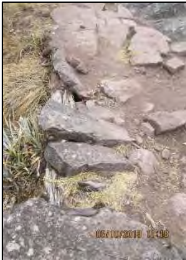
Nota: Camino Empedrado
