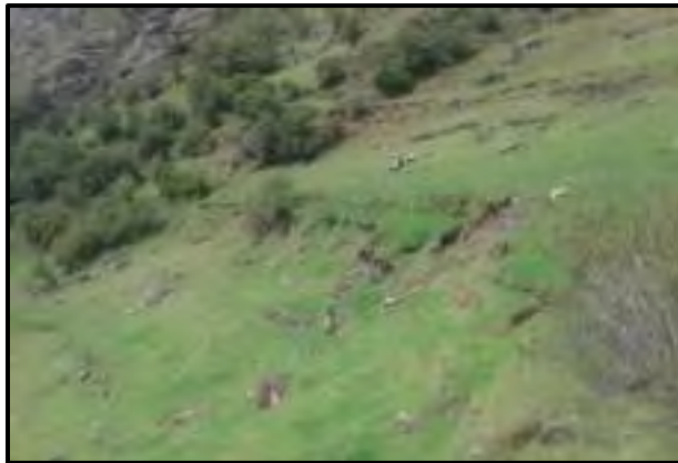
CAMINO CORTE TALUD
