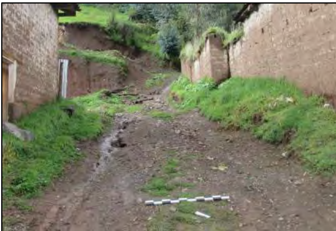
Camino Corte de Talud
