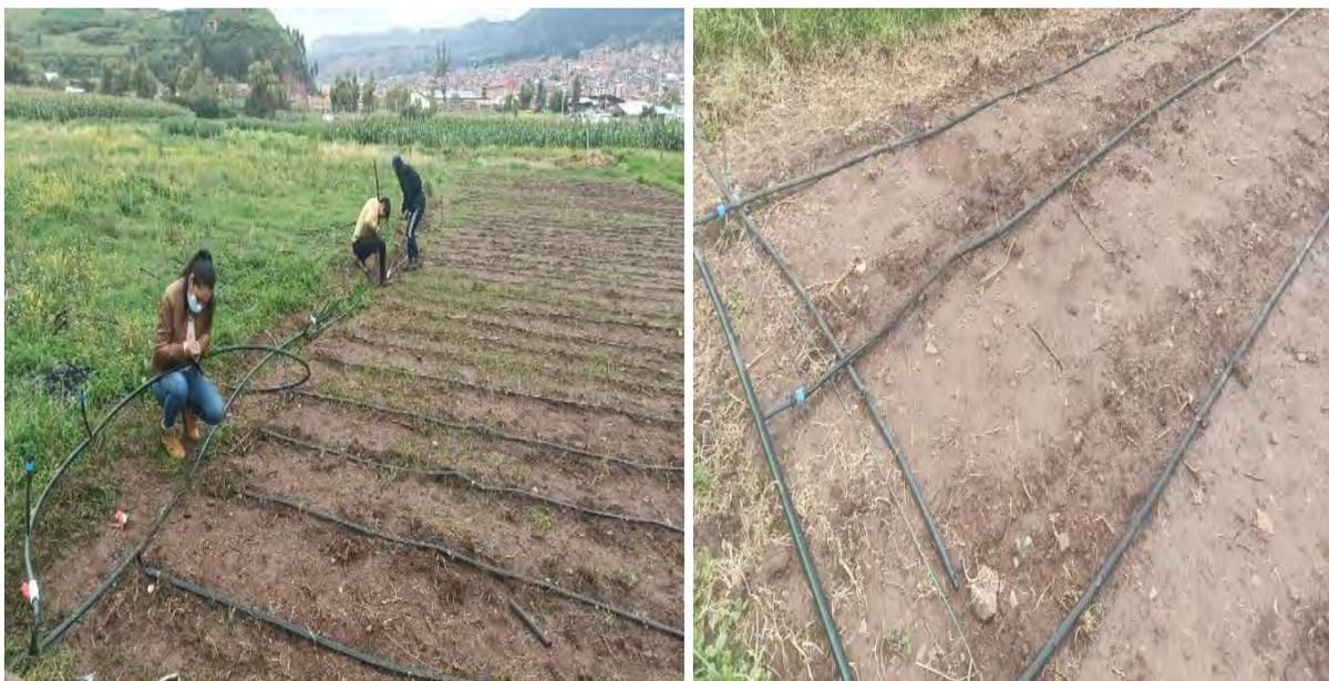
**Fotografía 17.** *Instalación de sistema para fertirriego*
