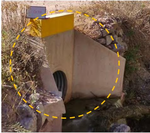
Foto 8. 5. Alcantarilla en buen estado de conservación
