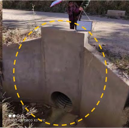
Foto 8. 6. Alcantarilla instalada debajo de la subrasante
