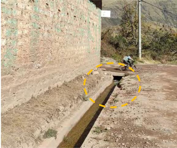
Foto 8. 9. Vista de cuneta en buen estado de conservación
