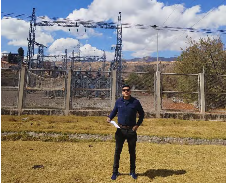
Fotografía N°1: Subestación de Cachimayo (Fuente: propia).
