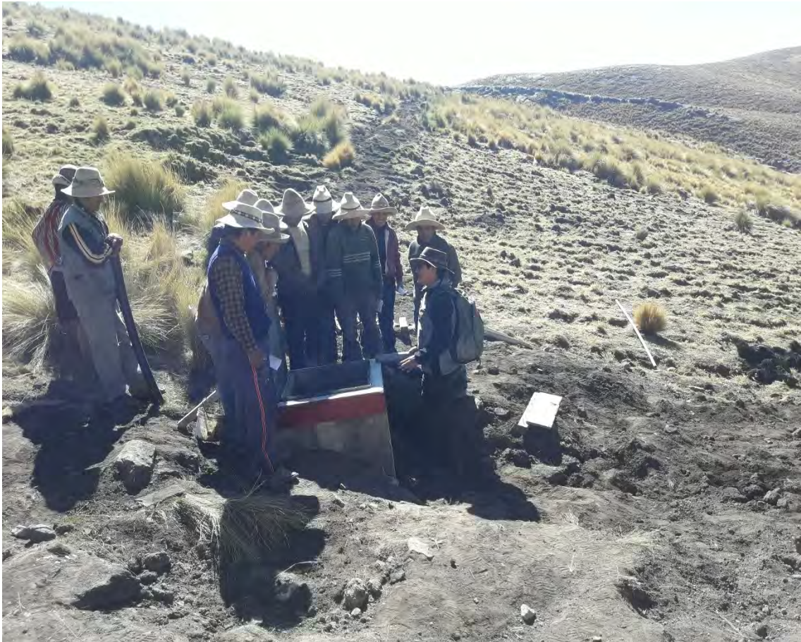
Imagen 5: Muestra de instalación de riego y saneamiento básico
