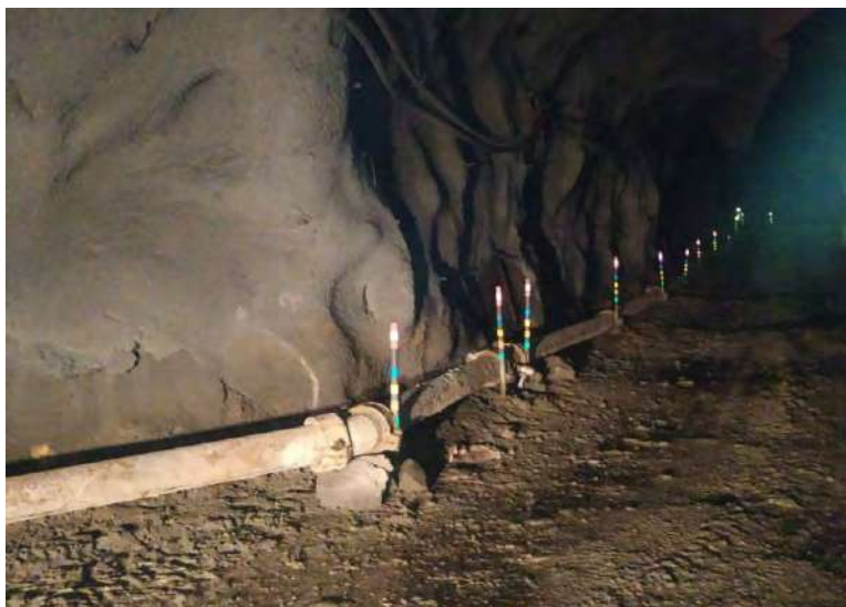
Fotografía N° 12 Tubería para Instalación de relleno en Veta Eliana
