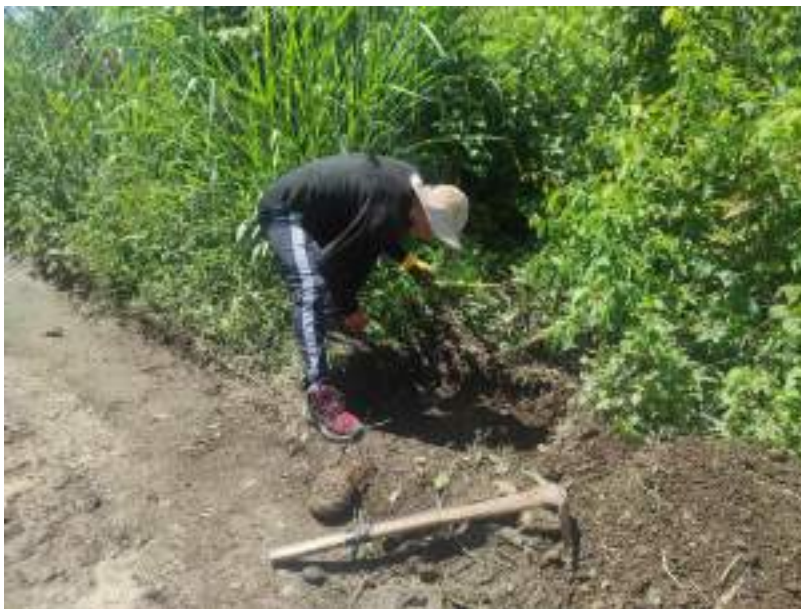
Excavación de calicata
