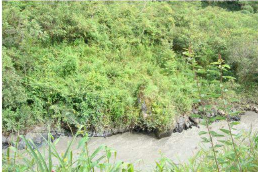
Vista de la margen izquierda del río Ocobamba
