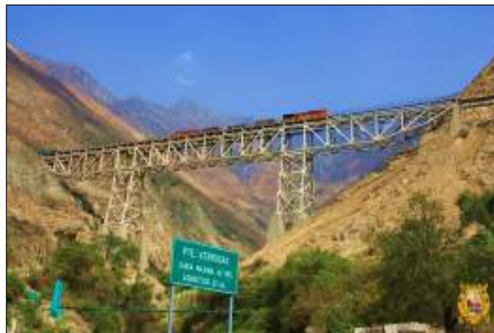
Figura 2. 20 Puente Ferroviario Daniel Alcides Carrión. (Fuente: Universidad Nacional Mayor De San Marcos)
