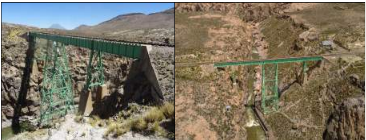
Figura 2. 18 Puente Ferroviario Sumbay- Arequipa. (Fuente: Fotografía Propia)
