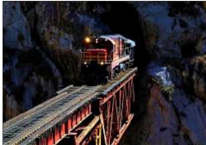
Figura 2. 19 Puente Ferroviario Infiernillo. (Fuente: Railpictures.net)
