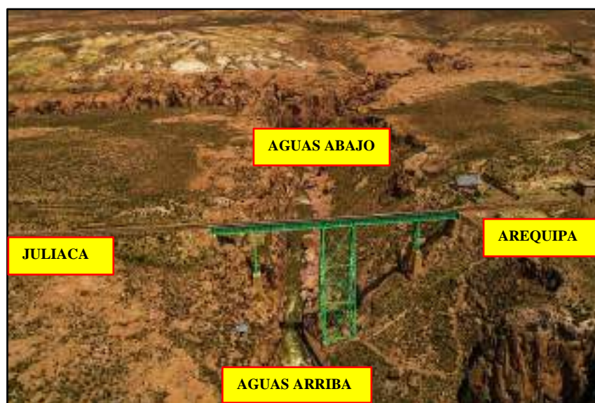
Figura 6. 1 Puente ferroviario Sumbay – Arequipa (Fuente: Fotografía Propia)
